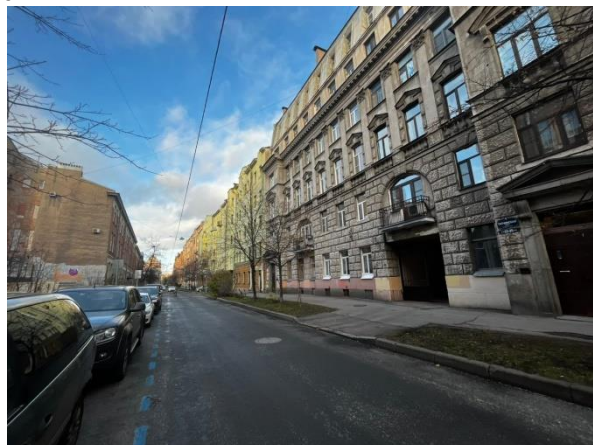
Фото 2. Ближайшее окружение. Вид здания, в котором расположен Объект оценки
