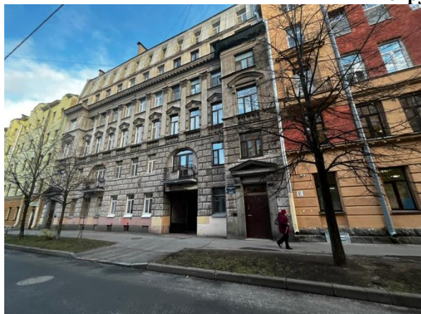
Фото 1. Вид здания, в котором расположен Объект оценки
