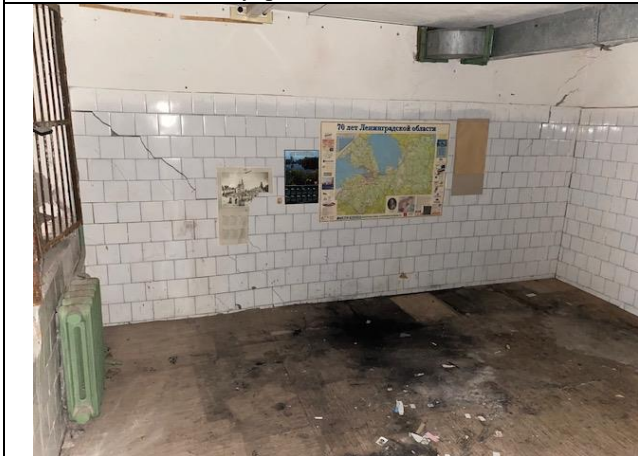
Фото № 9 – Внутреннее состояние помещения
