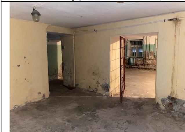
Фото № 13 – Внутреннее состояние помещения
