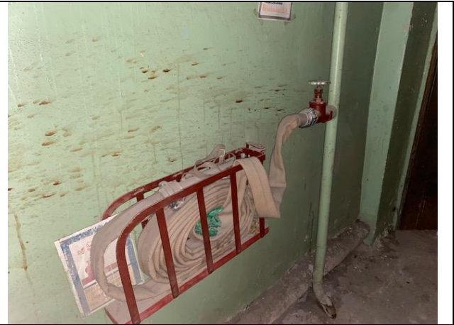
Фото № 8 – Внутреннее состояние помещения
