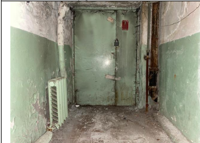
Фото № 17 – Внутреннее состояние помещения
