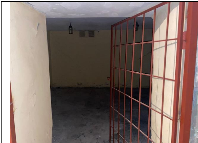
Фото № 15 – Внутреннее состояние помещения
