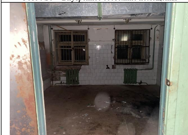
Фото № 11 – Внутреннее состояние помещения
