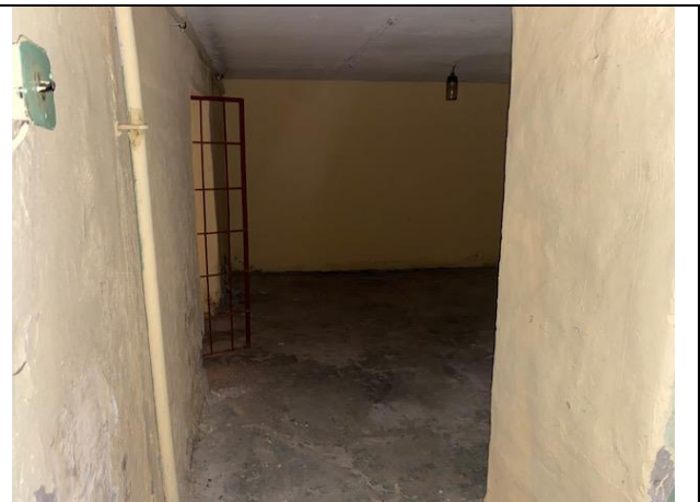
Фото № 16 – Внутреннее состояние помещения
