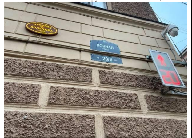
Фото 10. Адрес Объекта оценки
