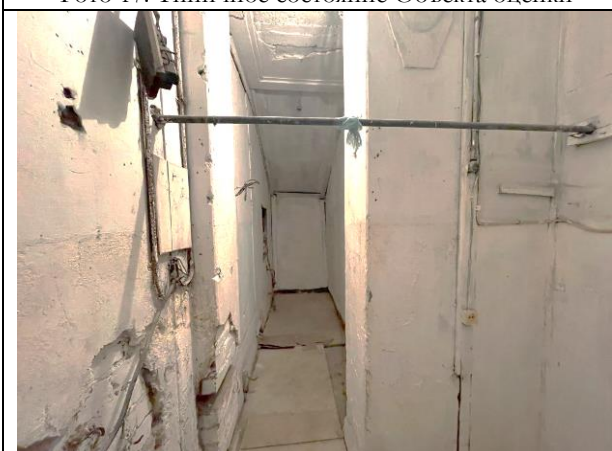
Фото 19. Типичное состояние Объекта оценки
