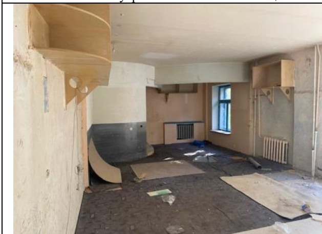
Фото № 9 – Внутреннее состояние помещения
