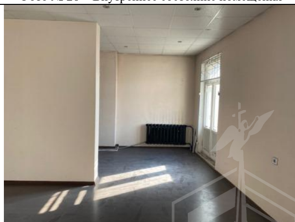
Фото № 22 – Внутреннее состояние помещения
