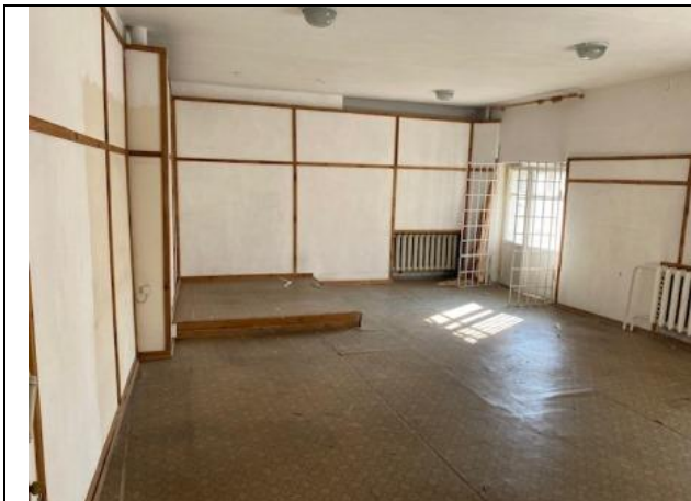
Фото № 15 – Внутреннее состояние помещения
