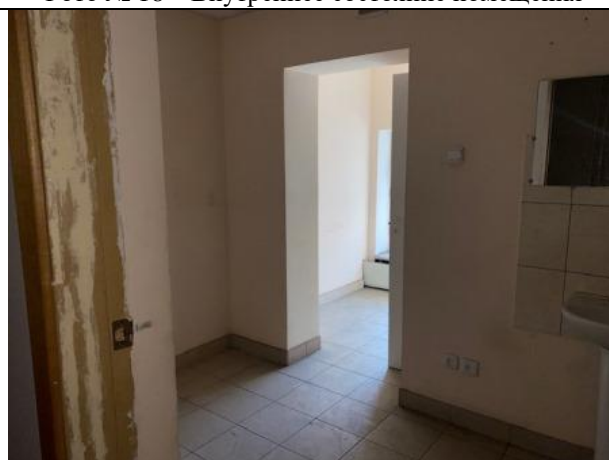
Фото № 20 – Внутреннее состояние помещения
