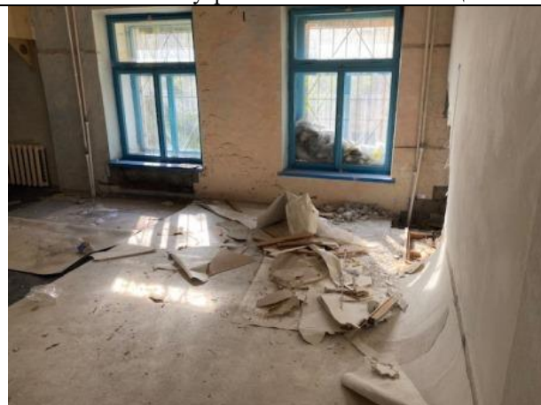
Фото № 10 – Внутреннее состояние помещения
