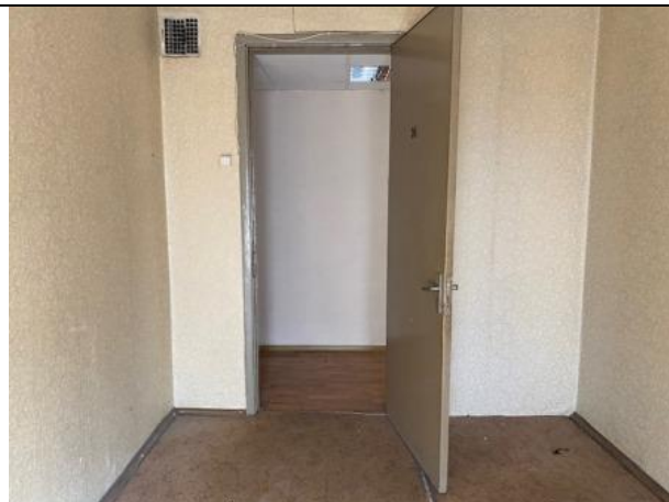
Фото № 16 – Внутреннее состояние помещения
