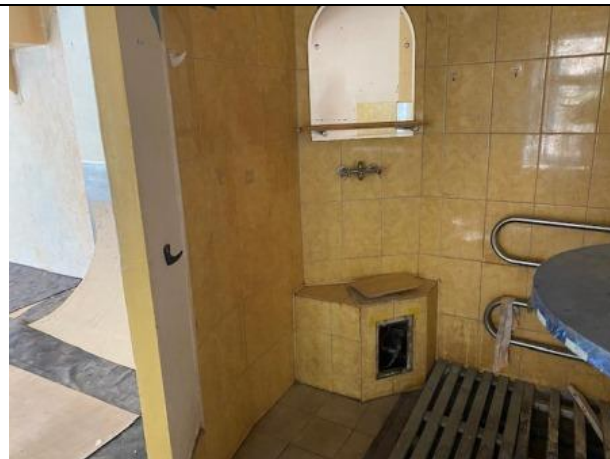
Фото № 8 – Внутреннее состояние помещения
