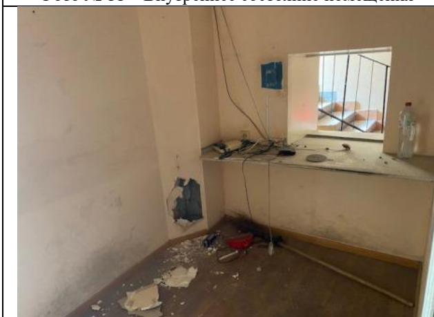
Фото № 13 – Внутреннее состояние помещения
