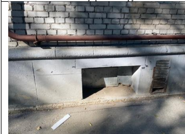
Фото № 9 – Окна помещения
