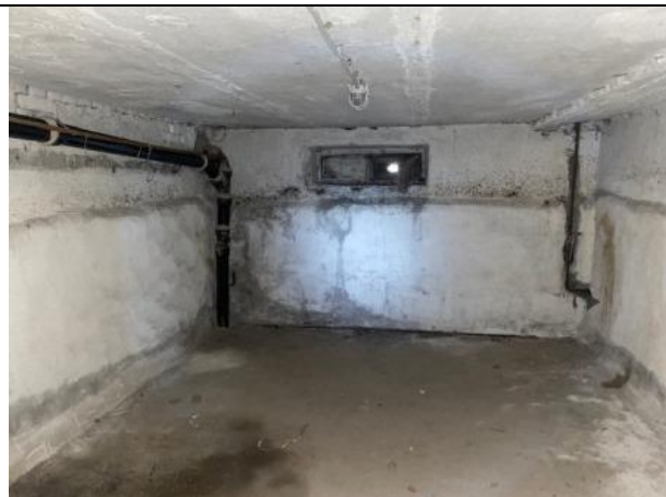
Фото № 32 – Внутреннее состояние помещения
