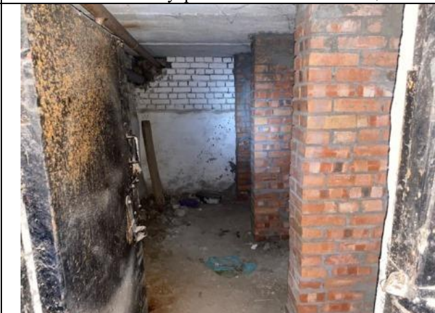
Фото № 26 – Внутреннее состояние помещения
