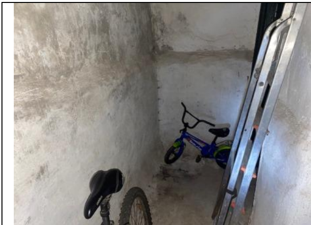
Фото № 15 – Внутреннее состояние помещения
