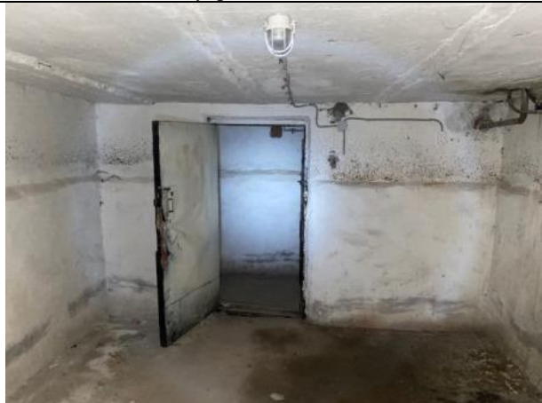
Фото № 33 – Внутреннее состояние помещения
