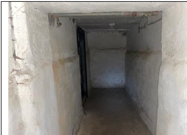
Фото № 31 – Внутреннее состояние помещения
