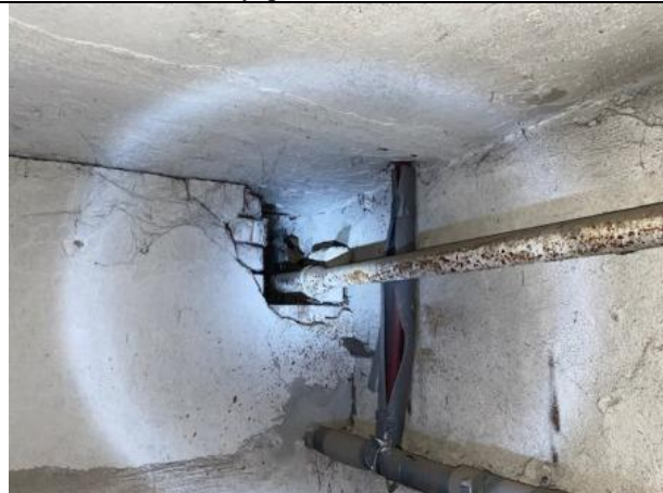
Фото № 34 – Внутреннее состояние помещения
