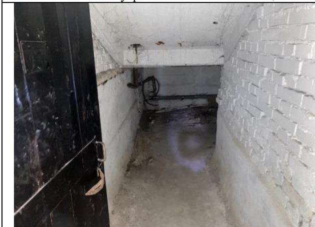
Фото № 17 – Внутреннее состояние помещения
