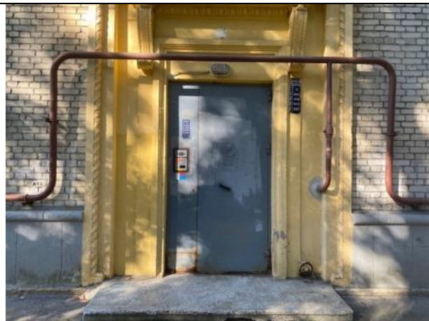
Фото № 8 – Вход общий со двора
