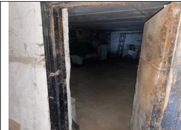
Фото № 24 – Внутреннее состояние помещения
