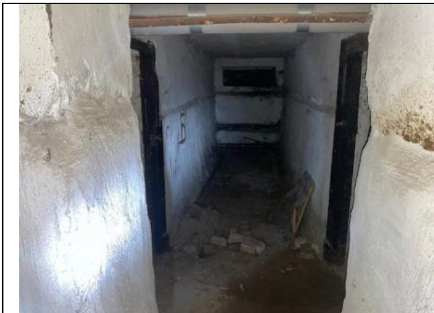
Фото № 23 – Внутреннее состояние помещения
