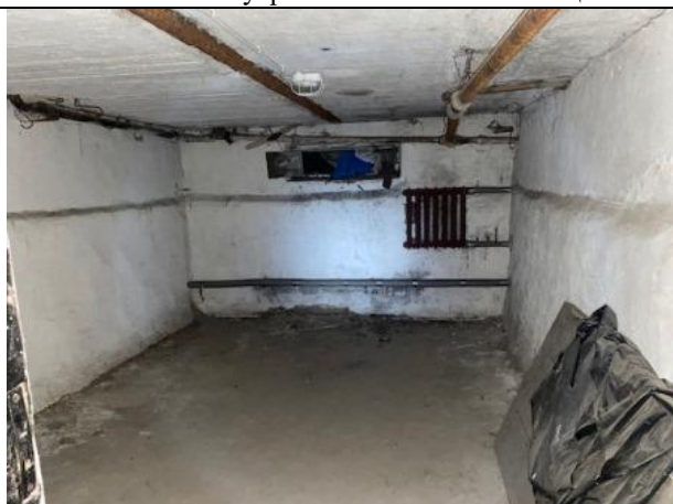
Фото № 37 – Внутреннее состояние помещения
