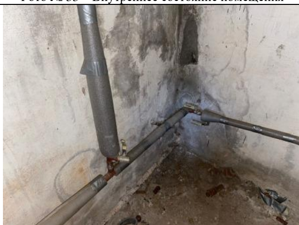
Фото № 35 – Внутреннее состояние помещения
