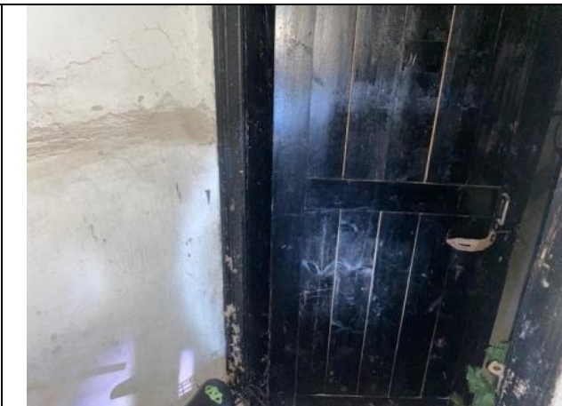
Фото № 16 – Внутреннее состояние помещения
