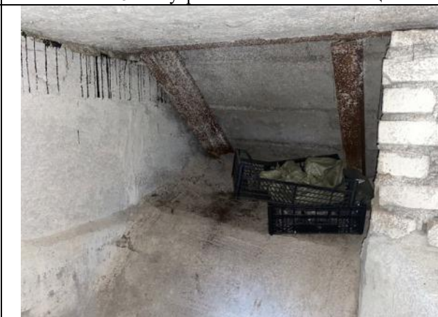
Фото № 20 – Внутреннее состояние помещения
