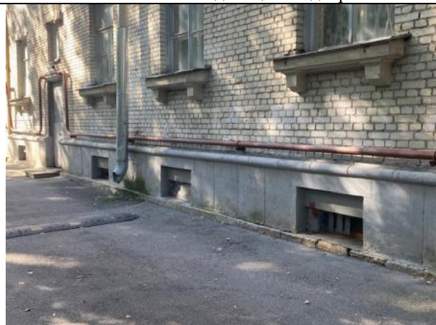
Фото № 10 – Окна помещения
