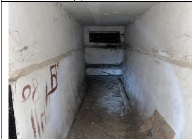
Фото № 25 – Внутреннее состояние помещения
