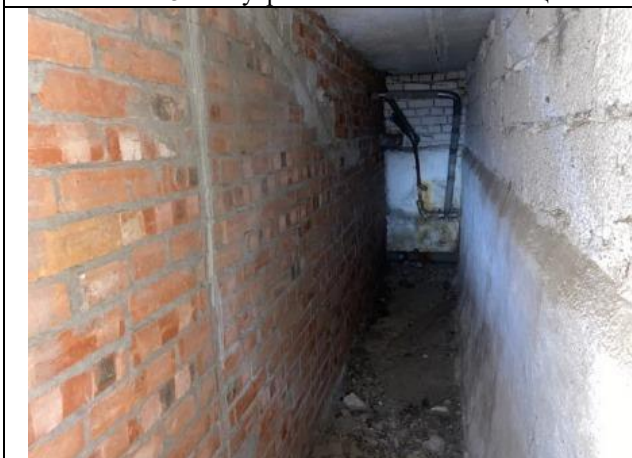
Фото № 27 – Внутреннее состояние помещения
