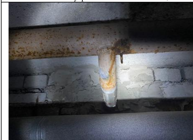
Фото № 29 – Внутреннее состояние помещения
