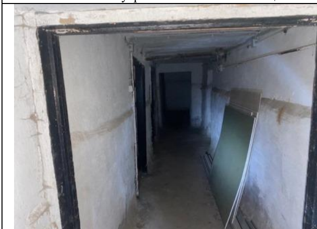
Фото № 21 – Внутреннее состояние помещения
