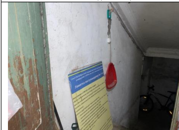
Фото № 13 – Внутреннее состояние помещения
