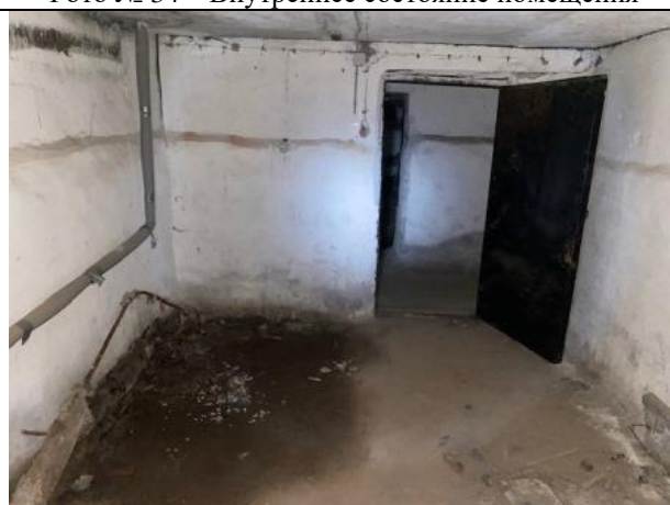
Фото № 36 – Внутреннее состояние помещения
