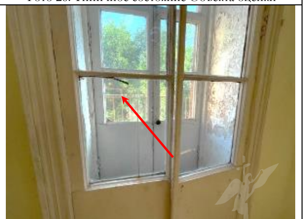
Фото 28. Типичное состояние Объекта оценки (выход на балкон)
