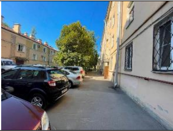
Фото 13. Внутривдворовая территория Объекта оценки
