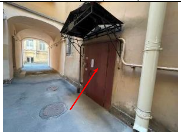
Фото 58. Проход через арку к Объекту оценки (входная группа Объекта оценки, второй вход)
