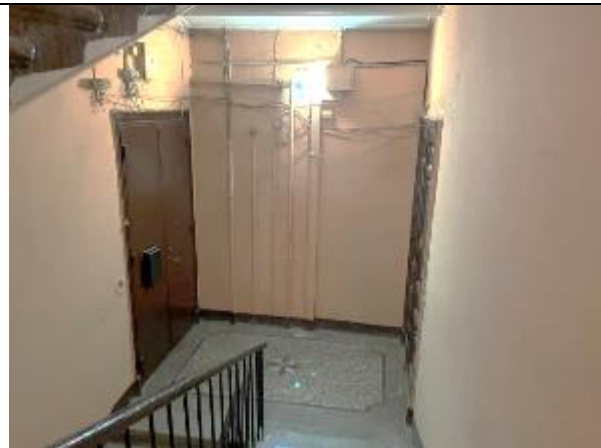
Фото 55. Лестничный проём Объекта оценки
