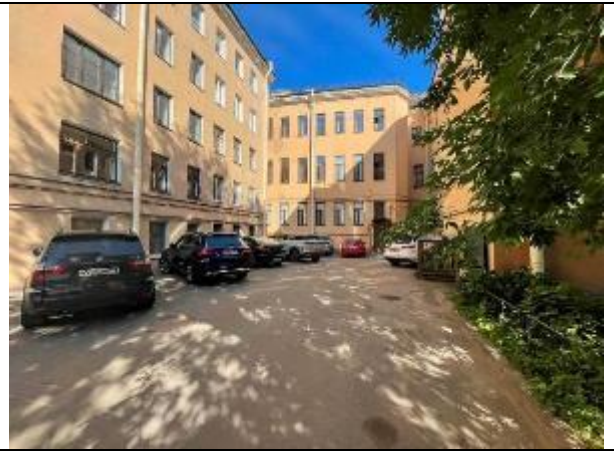
Фото 14. Внутривдворовая территория Объекта оценки
