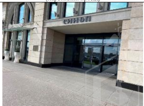
Фото 4. Ближайшее окружение Объекта оценки (Синопская набережная)
