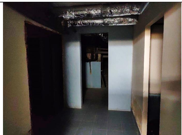
Фото 10. Внутреннее состояние Объекта оценки
