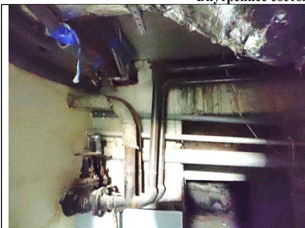
Фото 7. Внутреннее состояние Объекта оценки
