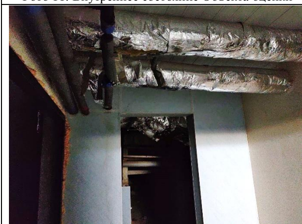
Фото 13. Внутреннее состояние Объекта оценки
