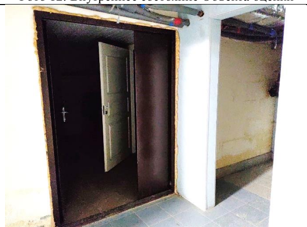
Фото 14. Внутреннее состояние Объекта оценки
