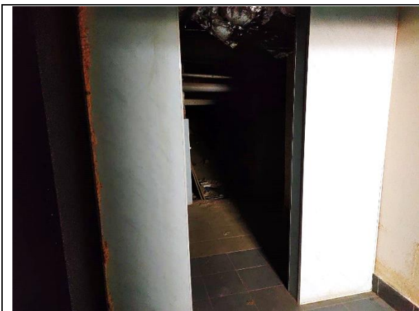
Фото 9. Внутреннее состояние Объекта оценки
