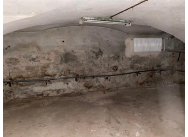
Фото № 18 – Внутреннее состояние помещения
