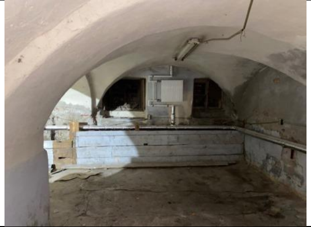
Фото № 16 – Внутреннее состояние помещения
