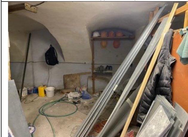
Фото № 9 – Внутреннее состояние помещения
