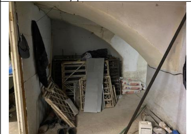
Фото № 10 – Внутреннее состояние помещения
