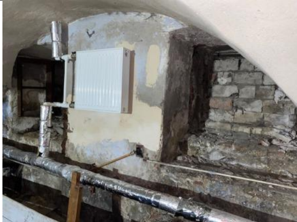
Фото № 17 – Внутреннее состояние помещения
