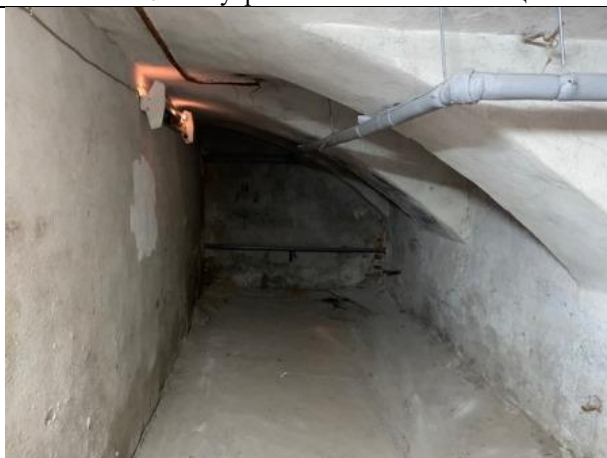
Фото № 19 – Внутреннее состояние помещения
