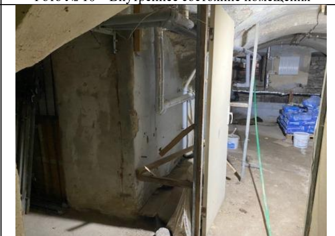
Фото № 12 – Внутреннее состояние помещения
