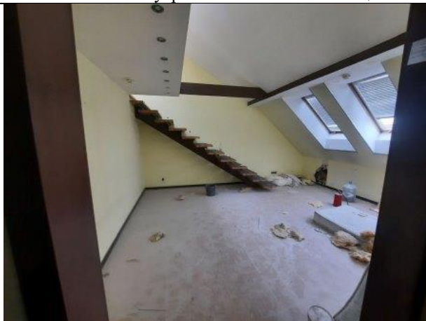
Фото № 19 – Внутреннее состояние помещения
