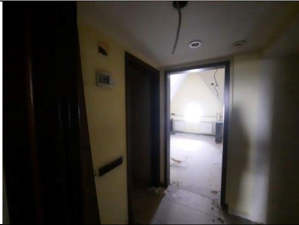
Фото № 15 – Внутреннее состояние помещения
