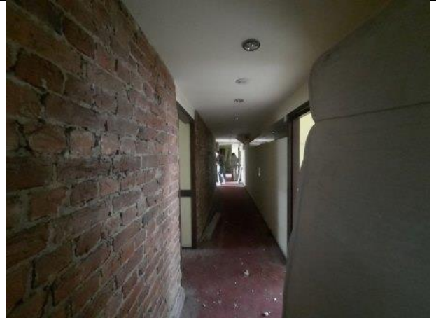
Фото № 18 – Внутреннее состояние помещения
