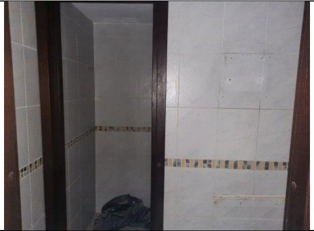
Фото № 16 – Внутреннее состояние помещения
