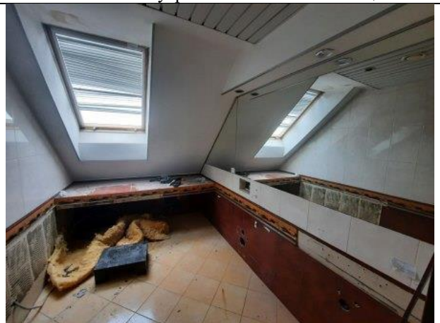
Фото № 20 – Внутреннее состояние помещения
