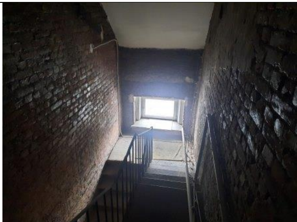
Фото № 7 – Лестничный пролет
