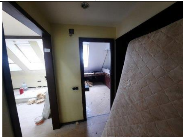
Фото № 10 – Внутреннее состояние помещения
