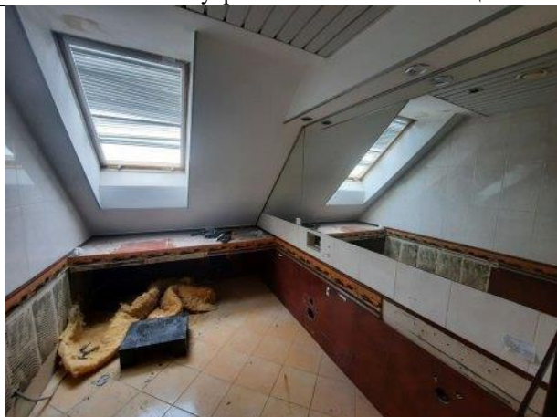
Фото № 13 – Внутреннее состояние помещения
