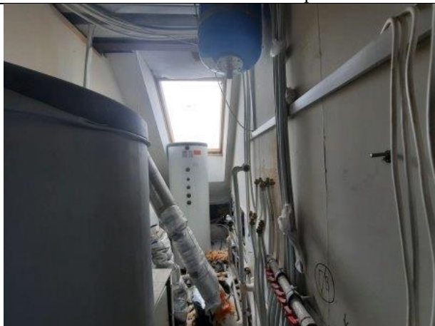
Фото № 9 – Внутреннее состояние помещения
