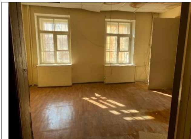
Фото № 15 – Внутреннее состояние помещения
