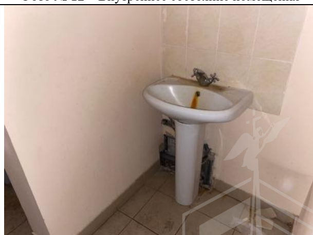
Фото № 14 – Внутреннее состояние помещения
