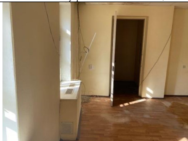
Фото № 18 – Внутреннее состояние помещения
