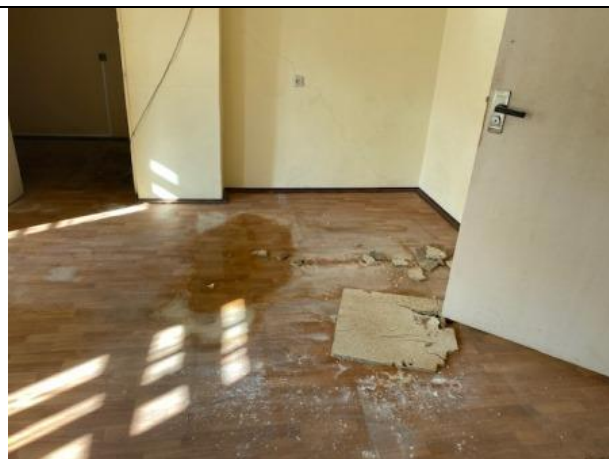
Фото № 16 – Внутреннее состояние помещения
