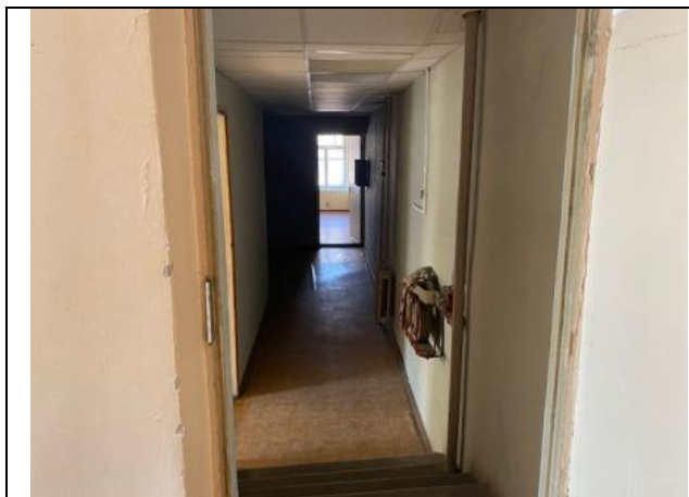
Фото № 7 – Внутреннее состояние помещения
