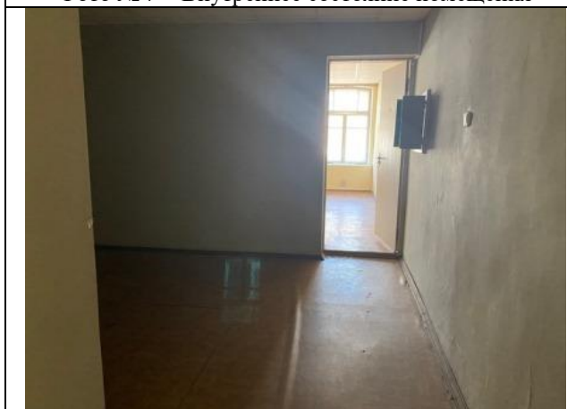
Фото № 9 – Внутреннее состояние помещения
