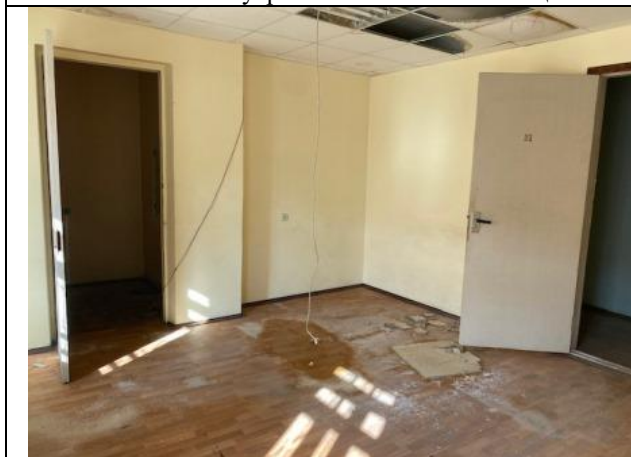
Фото № 17 – Внутреннее состояние помещения
