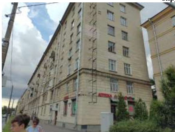
Фото 1. Вид здания Объекта оценки, с улицы
