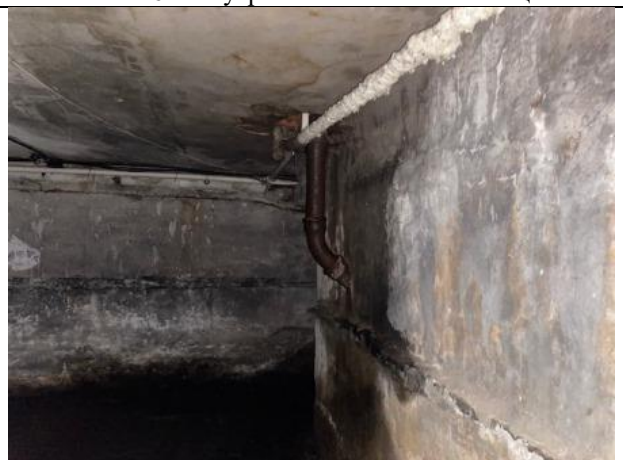
Фото № 28 – Внутреннее состояние помещения
