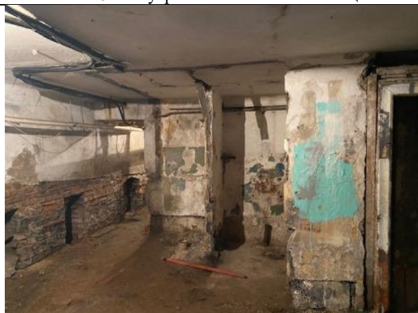
Фото № 10 – Внутреннее состояние помещения
