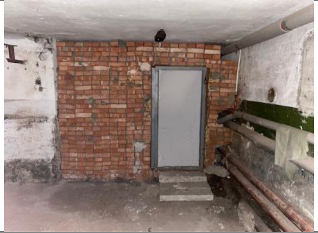
Фото № 34 – Внутреннее состояние помещения
