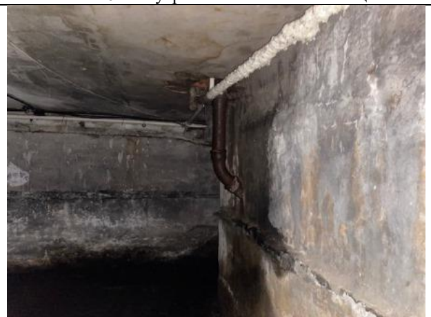
Фото № 28 – Внутреннее состояние помещения
