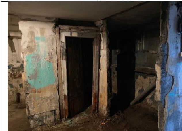
Фото № 9 – Внутреннее состояние помещения
