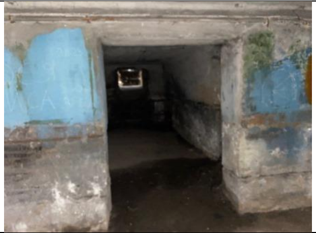
Фото № 24 – Внутреннее состояние помещения
