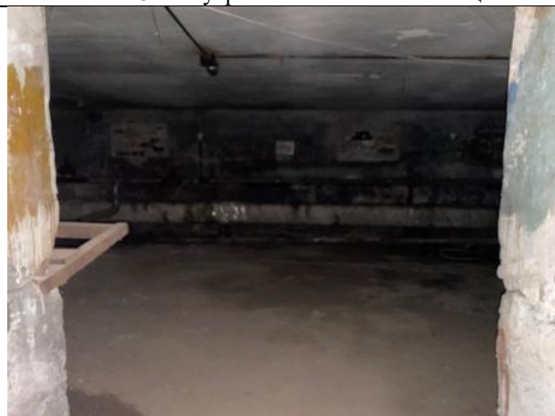
Фото № 20 – Внутреннее состояние помещения
