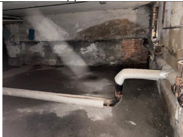
Фото № 18 – Внутреннее состояние помещения
