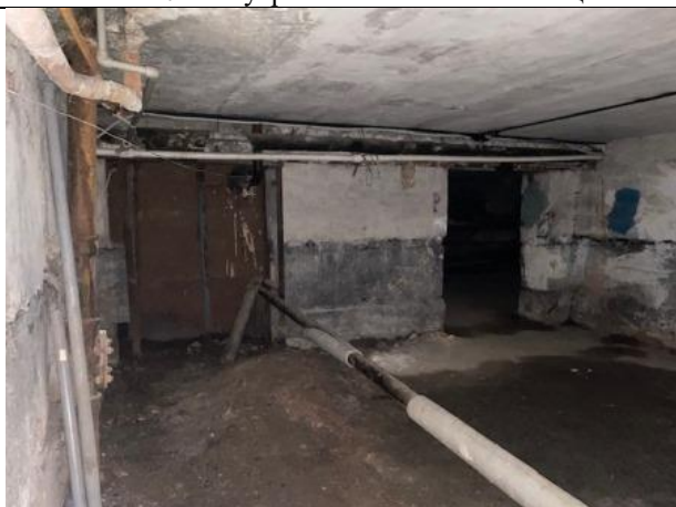
Фото № 19 – Внутреннее состояние помещения
