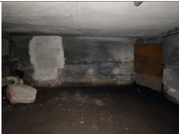
Фото № 23 – Внутреннее состояние помещения
