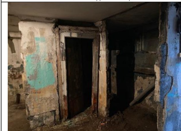
Фото № 9 – Внутреннее состояние помещения
