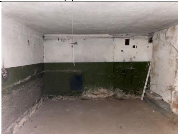
Фото № 35 – Внутреннее состояние помещения
