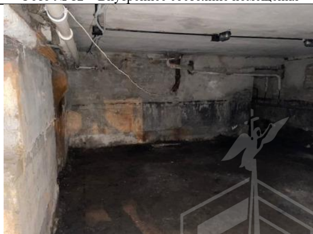
Фото № 14 – Внутреннее состояние помещения
