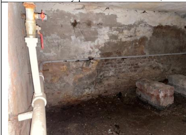
Фото № 41 – Внутреннее состояние помещения
