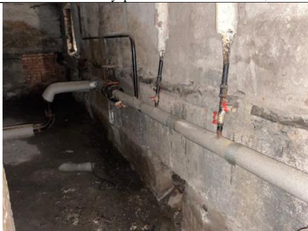
Фото № 17 – Внутреннее состояние помещения
