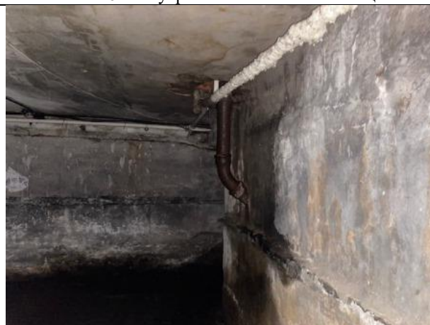
Фото № 28 – Внутреннее состояние помещения
