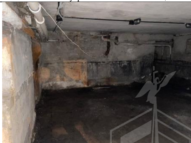
Фото № 14 – Внутреннее состояние помещения
