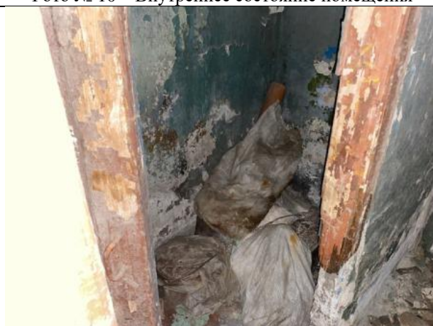
Фото № 12 – Внутреннее состояние помещения
