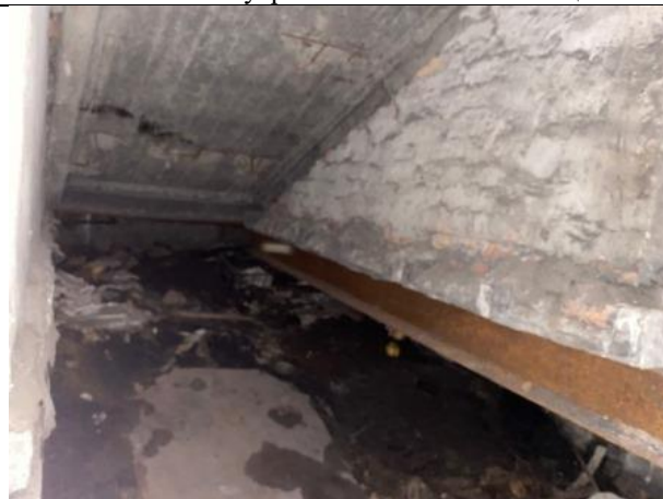
Фото № 26 – Внутреннее состояние помещения
