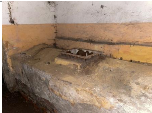
Фото № 40 – Внутреннее состояние помещения
