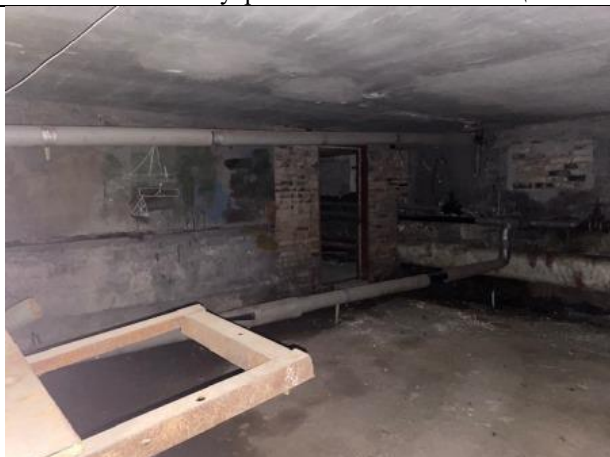
Фото № 21 – Внутреннее состояние помещения
