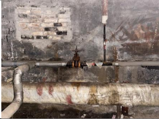
Фото № 33 – Внутреннее состояние помещения
