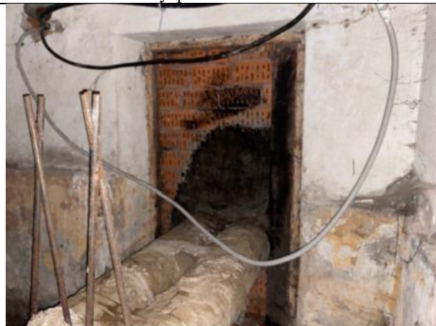
Фото № 42 – Внутреннее состояние помещения
