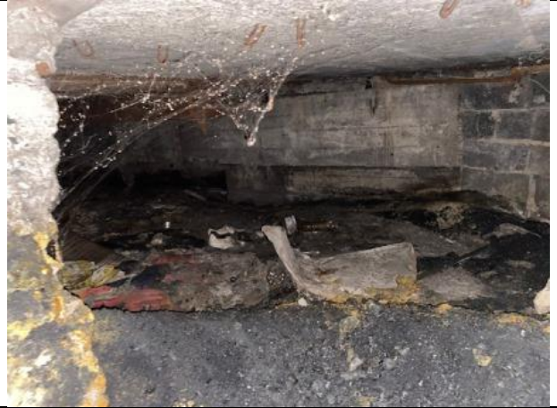
Фото № 32 – Внутреннее состояние помещения
