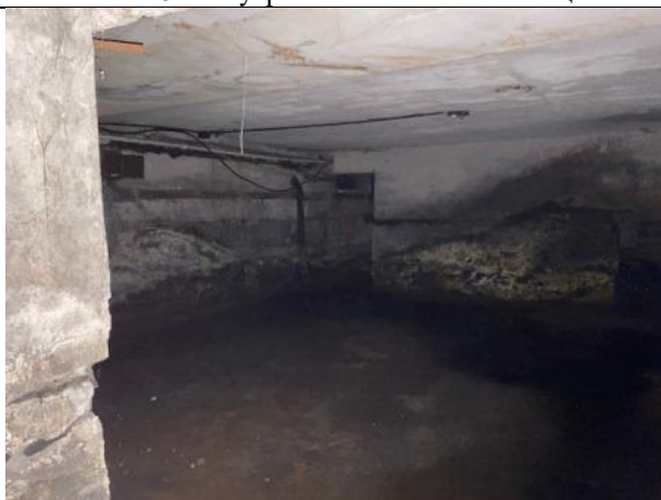
Фото № 27 – Внутреннее состояние помещения
