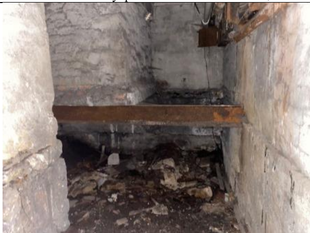
Фото № 25 – Внутреннее состояние помещения
