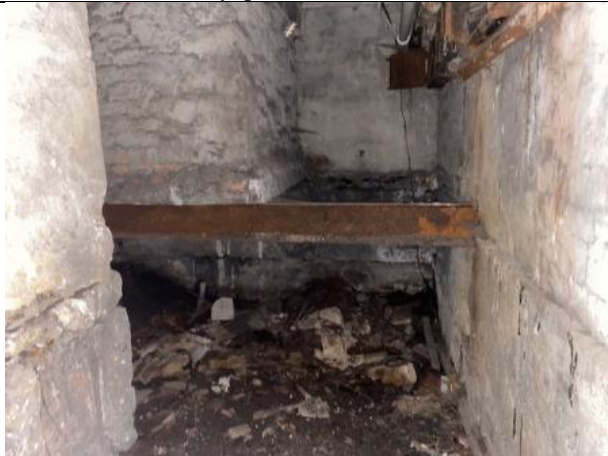
Фото № 25 – Внутреннее состояние помещения
