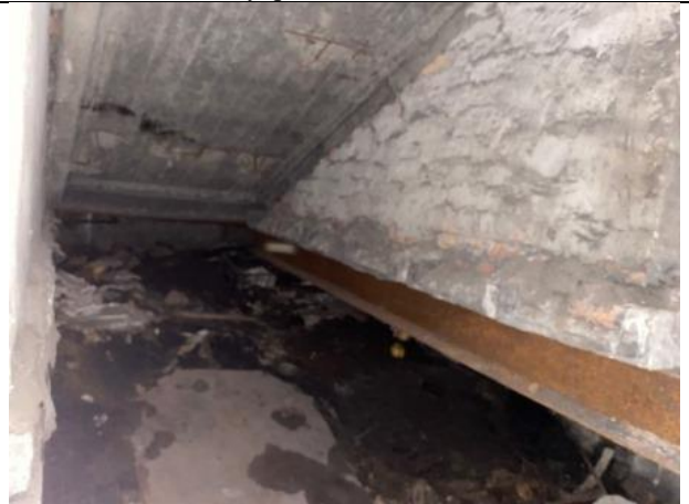
Фото № 26 – Внутреннее состояние помещения
