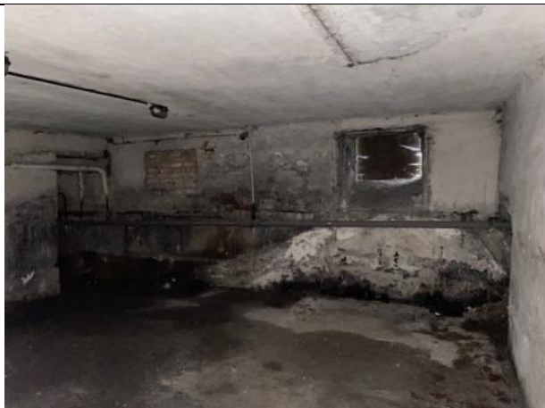
Фото № 15 – Внутреннее состояние помещения
