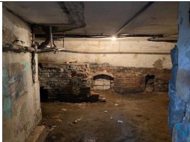
Фото № 8 – Внутреннее состояние помещения
