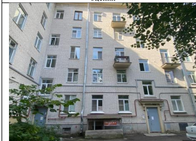
Фото № 3 – Здание, в котором находится Объект оценки и дворовая территория
