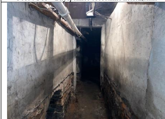
Фото № 13 – Внутреннее состояние помещения
