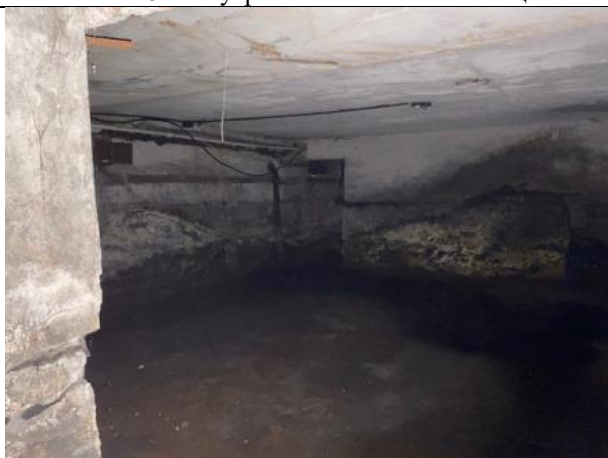
Фото № 27 – Внутреннее состояние помещения
