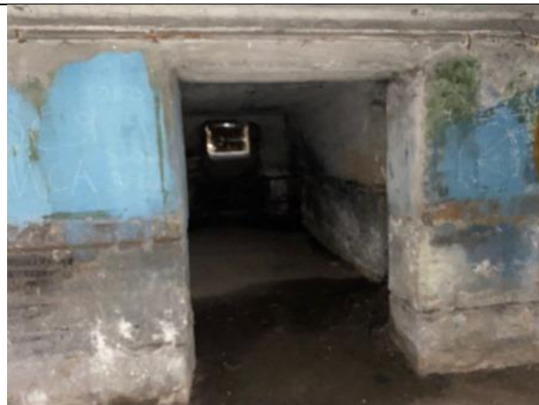
Фото № 24 – Внутреннее состояние помещения
