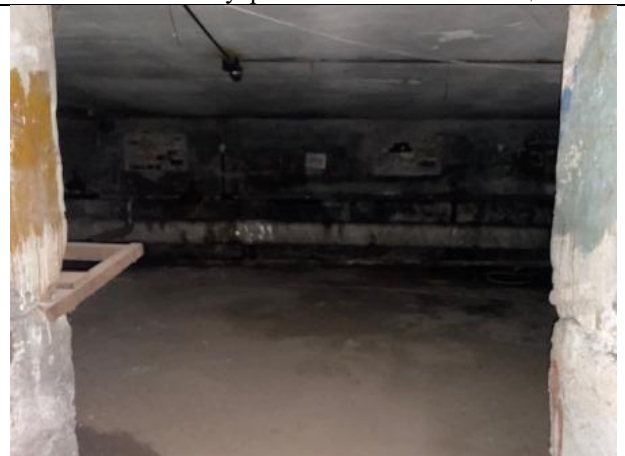
Фото № 20 – Внутреннее состояние помещения
