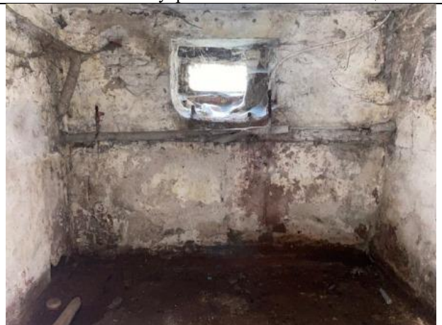
Фото № 36 – Внутреннее состояние помещения
