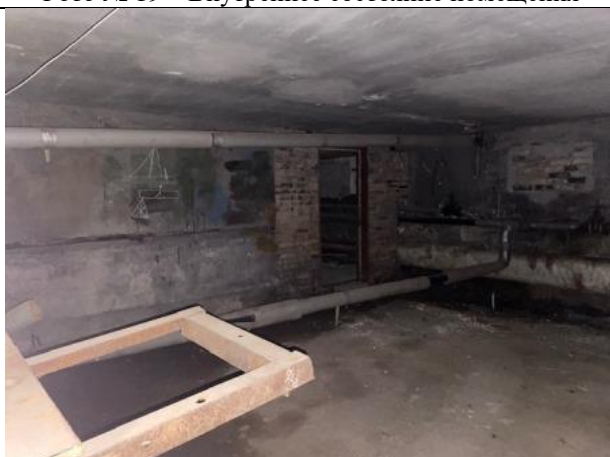
Фото № 21 – Внутреннее состояние помещения
