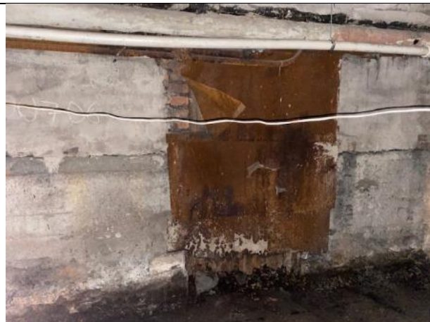
Фото № 16 – Внутреннее состояние помещения
