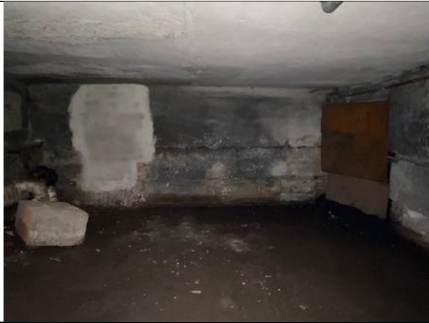
Фото № 23 – Внутреннее состояние помещения
