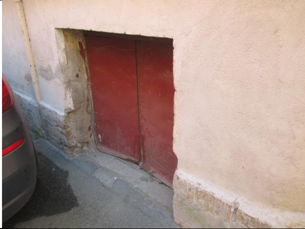
Фото № 7 – Окна помещения
