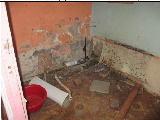
Фото № 13 – Внутреннее состояние помещения
