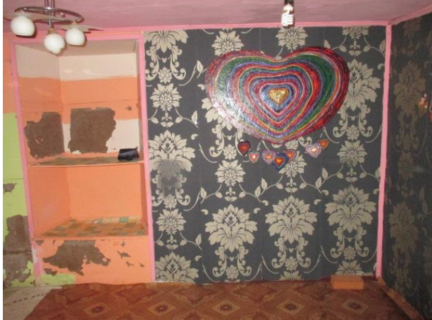
Фото № 17 – Внутреннее состояние помещения
