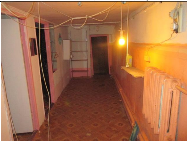
Фото № 11 – Внутреннее состояние помещения
