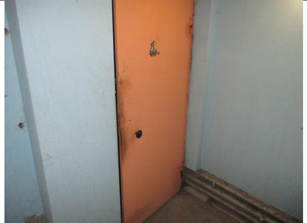
Фото № 10 – Вход в помещение
