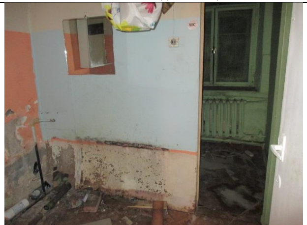
Фото № 12 – Внутреннее состояние помещения
