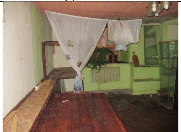
Фото № 20 – Внутреннее состояние помещения
