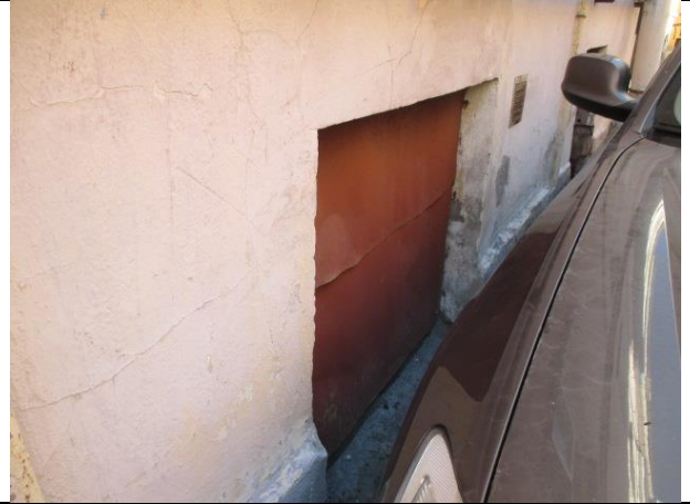
Фото № 8 – Окна помещения
