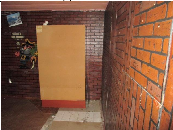
Фото № 19 – Внутреннее состояние помещения
