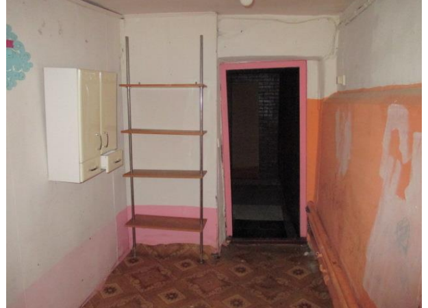
Фото № 18 – Внутреннее состояние помещения
