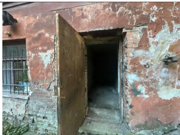
Фото № 8 – Вход в помещение со двора
