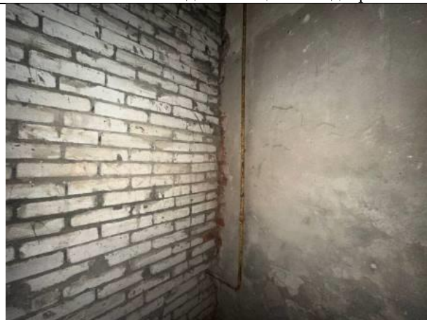
Фото № 10 – Внутреннее состояние помещения
