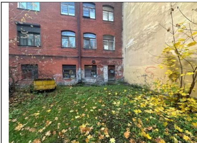
Фото № 7 – Вход в помещение со двора
