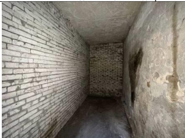
Фото № 9 – Внутреннее состояние помещения
