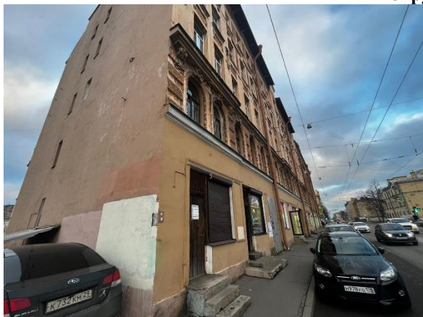
Фото 1. Вид здания, в котором расположен Объект оценки
