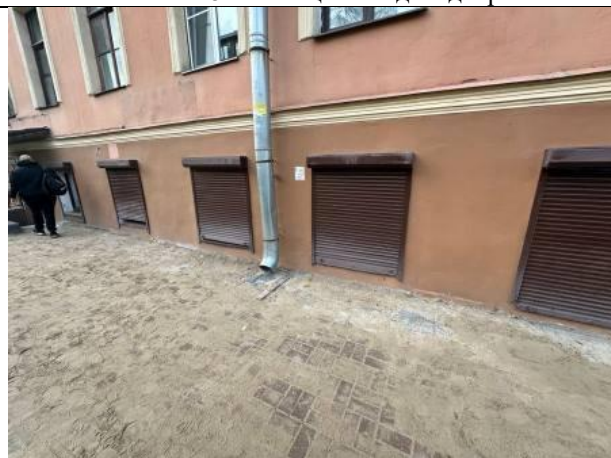
Фото № 10 – Окна помещения
