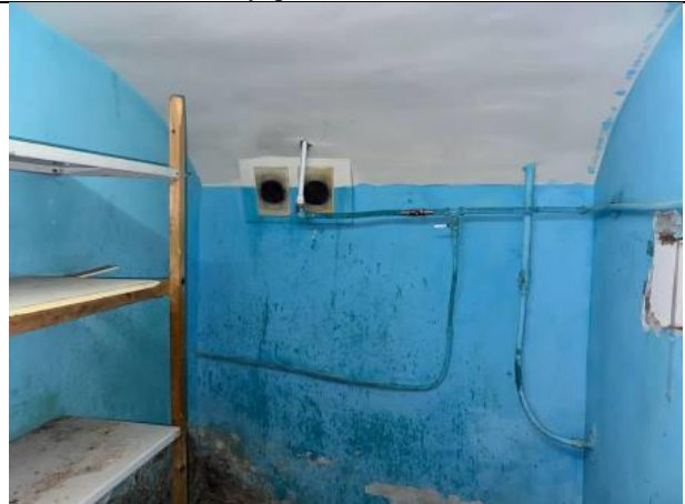
Фото № 16 – Внутреннее состояние помещения
