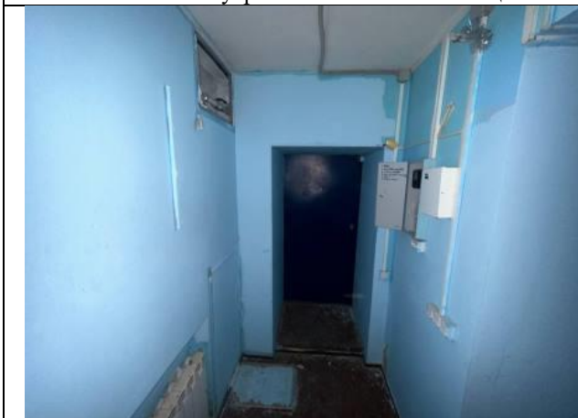
Фото № 19 – Внутреннее состояние помещения
