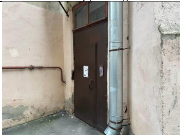
Фото № 8 – – Общий вход со двора
