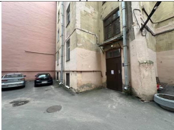
Фото № 7 – Общий вход со двора
