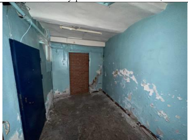
Фото № 18 – Внутреннее состояние помещения
