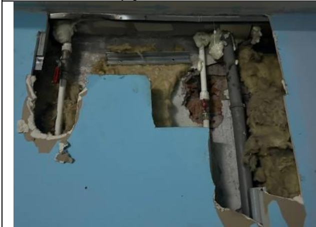
Фото № 15 – Внутреннее состояние помещения
