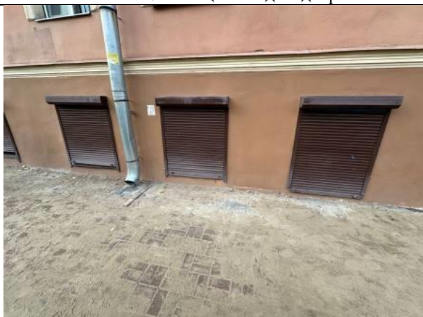
Фото № 9 – Окна помещения
