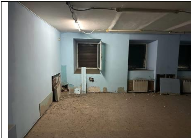
Фото № 13 – Внутреннее состояние помещения
