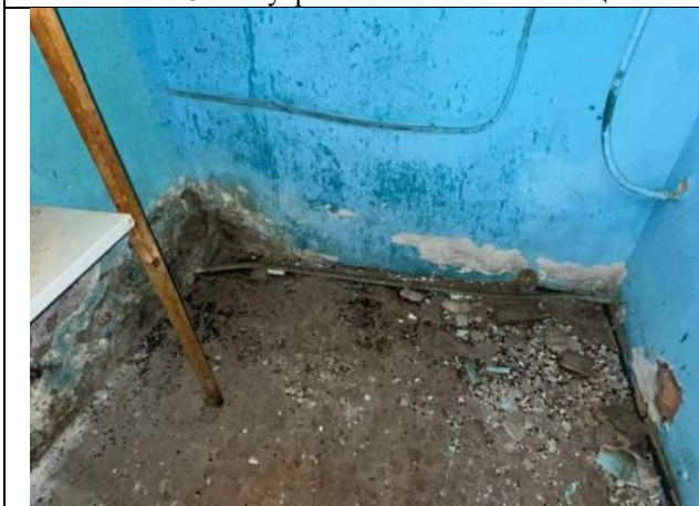
Фото № 17 – Внутреннее состояние помещения
