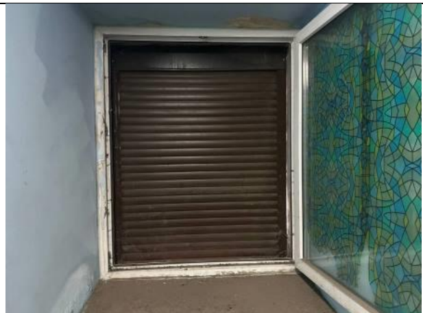
Фото № 14 – Внутреннее состояние помещения
