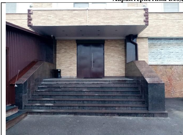
Фото 5. Общий вход с улицы
