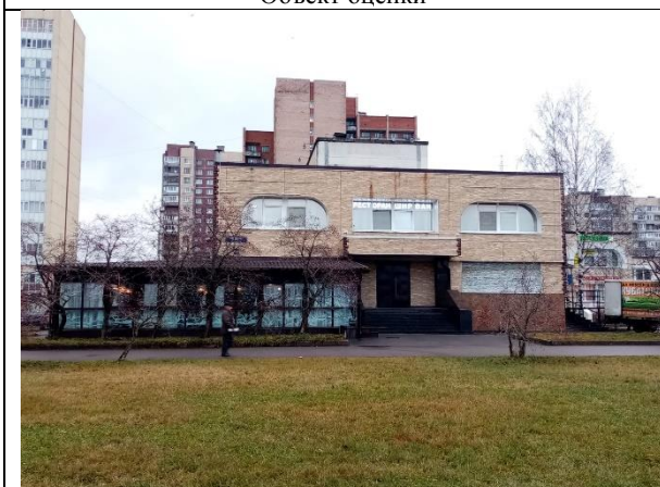
Фото 3. Вид здания, в котором расположен Объект оценки. Ближайшее окружение
