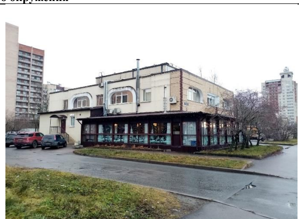
Фото 2. Вид здания, в котором расположен Объект оценки. Ближайшее окружение
