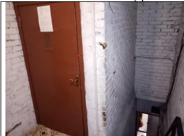
Фото 11. Внутреннее состояние Объекта оценки
