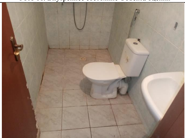
Фото 18. Внутреннее состояние Объекта оценки
