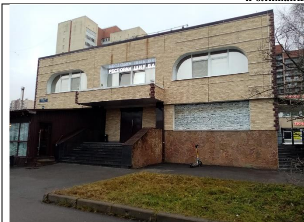
Фото 1. Вид здания, в котором расположен Объект оценки
