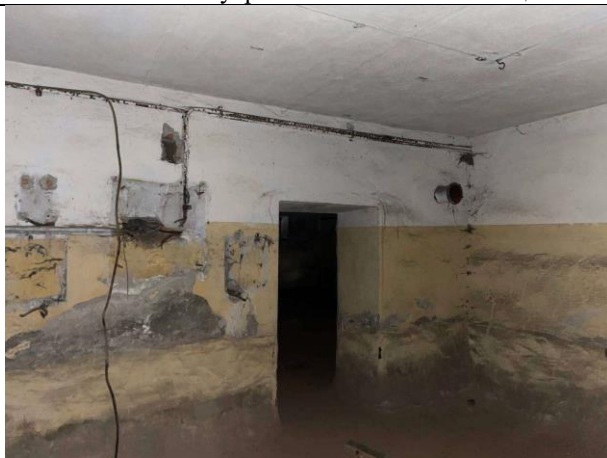
Фото № 17 – Внутреннее состояние помещения
