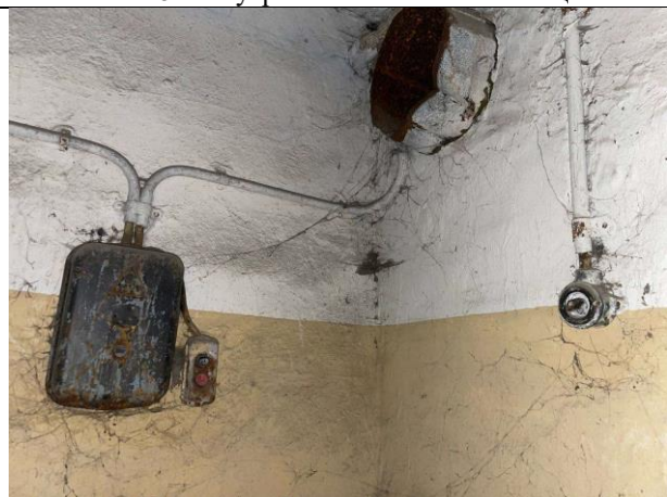
Фото № 10 – Внутреннее состояние помещения
