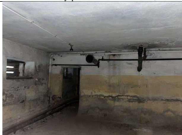
Фото № 8 – Внутреннее состояние помещения
