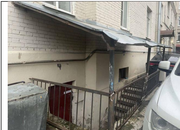
Фото № 5 – Вход в помещение со двора
