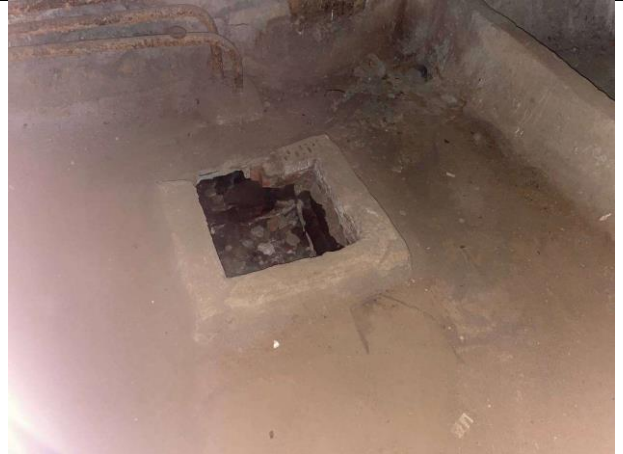
Фото № 16 – Внутреннее состояние помещения
