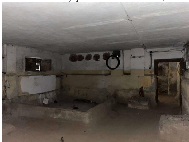
Фото № 19 – Внутреннее состояние помещения
