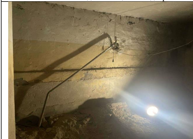
Фото № 7 – Внутреннее состояние помещения
