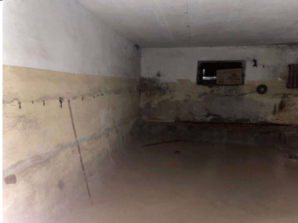
Фото № 15 – Внутреннее состояние помещения
