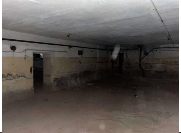
Фото № 14 – Внутреннее состояние помещения
