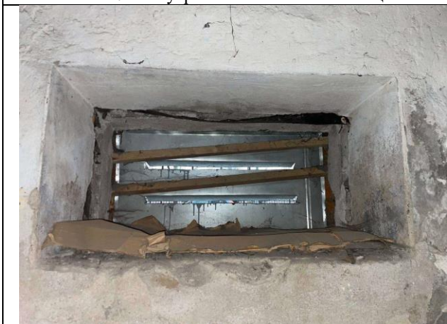
Фото № 9 – Внутреннее состояние помещения
