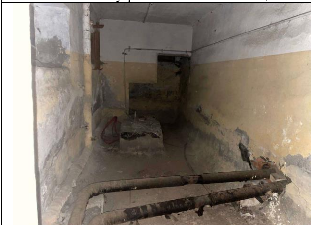
Фото № 11 – Внутреннее состояние помещения
