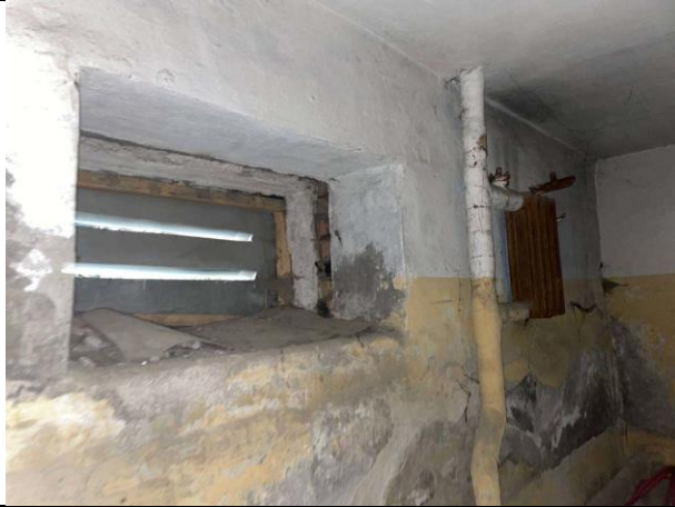
Фото № 13 – Внутреннее состояние помещения
