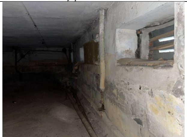
Фото № 18 – Внутреннее состояние помещения
