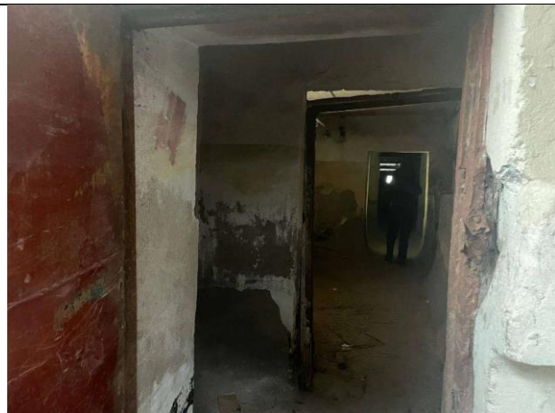
Фото № 6 – Внутреннее состояние помещения
