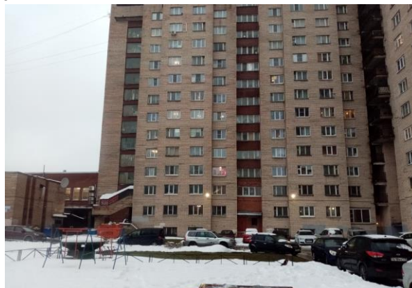
Фото 2. Вид здания Объекта оценки
