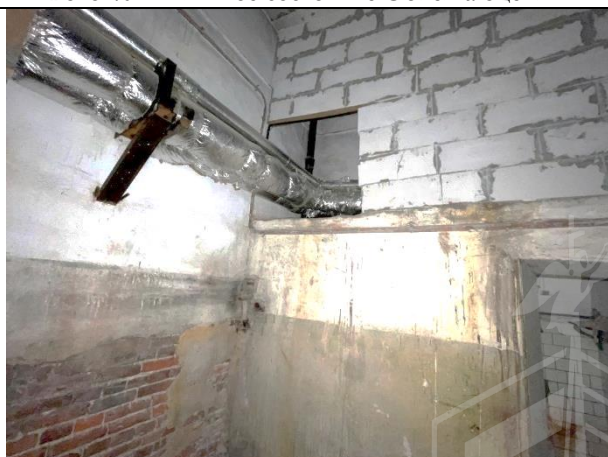
Фото 42. Типичное состояние Объекта оценки
