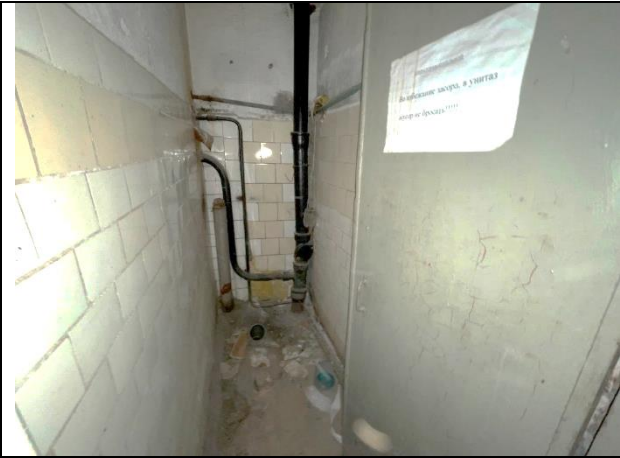
Фото 43. Типичное состояние Объекта оценки
