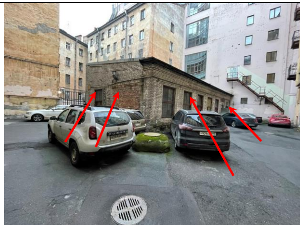
Фото 22. Вид здания расположения Объекта оценки, входная (со двора) и оконная группа Объекта оценки
