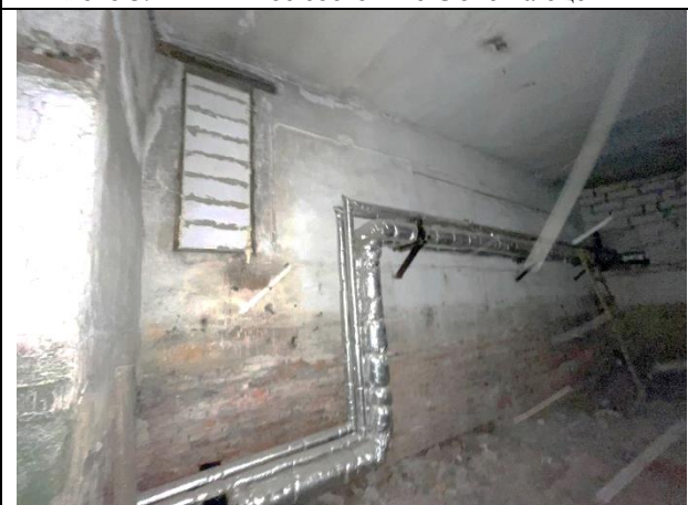
Фото 41. Типичное состояние Объекта оценки
