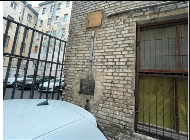
Фото 46. Типичное состояние Объекта оценки
