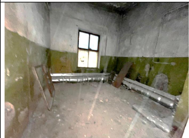
Фото 37. Типичное состояние Объекта оценки
