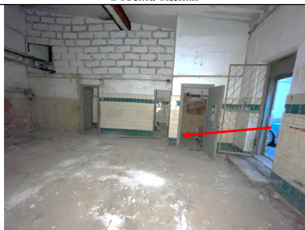
Фото 26. Входная группа объекта оценки, типичное состояние Объекта оценки
