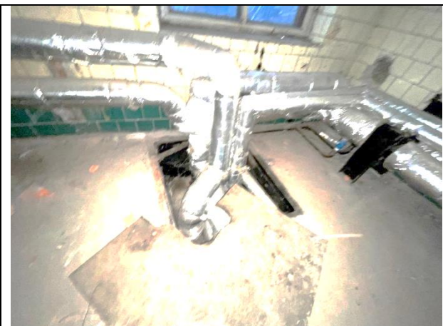
Фото 35. Типичное состояние Объекта оценки
