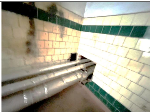
Фото 36. Типичное состояние Объекта оценки
