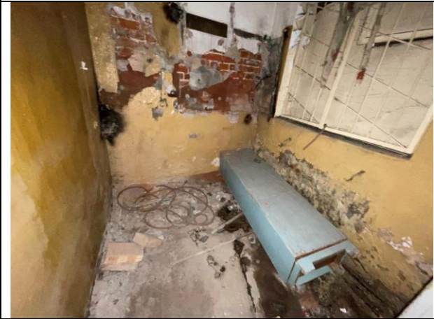
Фото 45. Типичное состояние Объекта оценки
