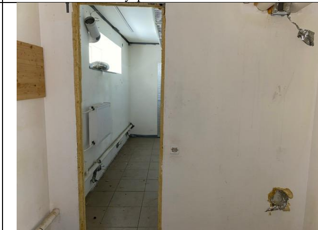
Фото № 24 – Внутреннее состояние помещения
