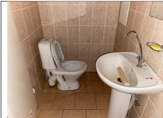
Фото № 29 – Внутреннее состояние помещения
