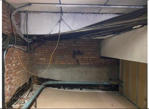
Фото № 14 – Внутреннее состояние помещения
