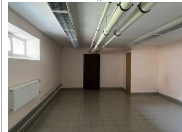
Фото № 9 – Внутреннее состояние помещения
