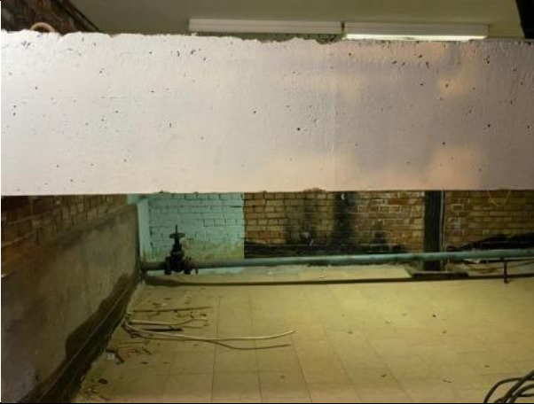
Фото № 13 – Внутреннее состояние помещения
