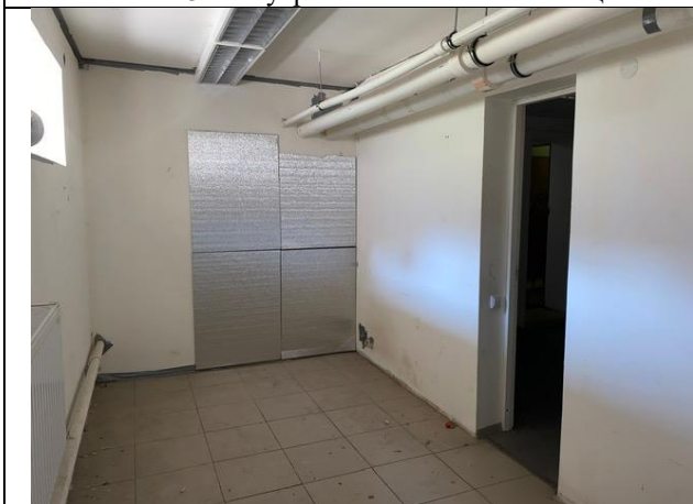
Фото № 25 – Внутреннее состояние помещения
