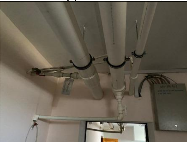
Фото № 17 – Внутреннее состояние помещения
