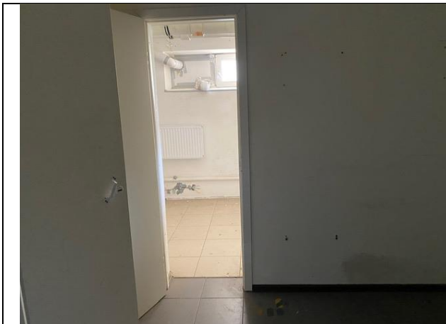
Фото № 21 – Внутреннее состояние помещения
