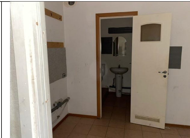
Фото № 22 – Внутреннее состояние помещения
