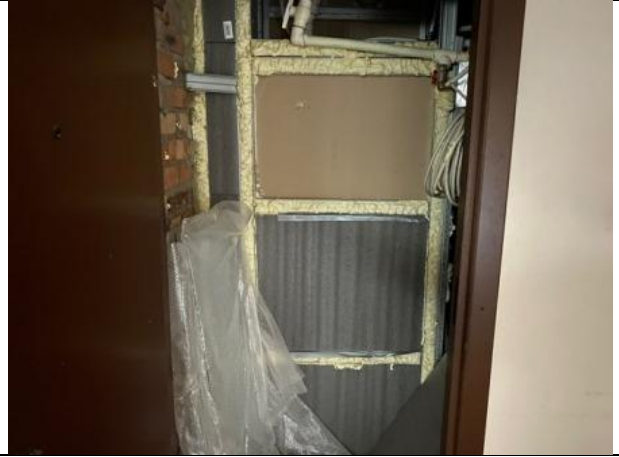
Фото № 16 – Внутреннее состояние помещения
