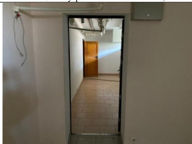
Фото № 10 – Внутреннее состояние помещения
