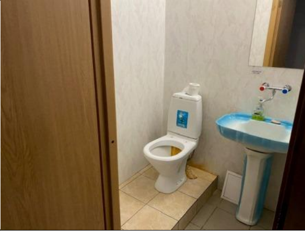
Фото № 15 – Внутреннее состояние помещения
