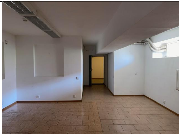
Фото № 30 – Внутреннее состояние помещения
