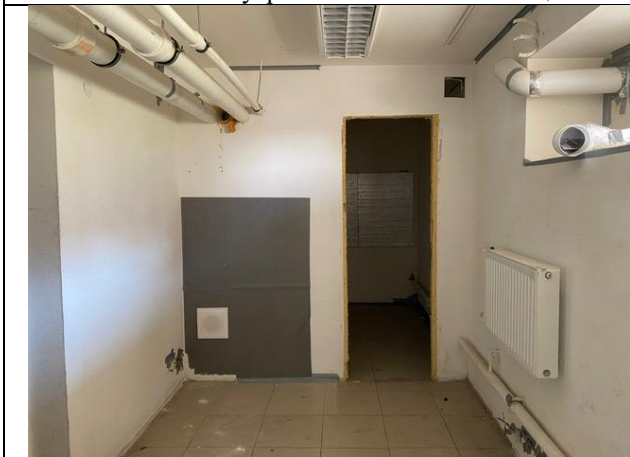
Фото № 23 – Внутреннее состояние помещения
