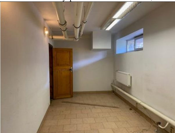
Фото № 19 – Внутреннее состояние помещения
