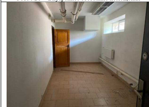
Фото № 11 – Внутреннее состояние помещения
