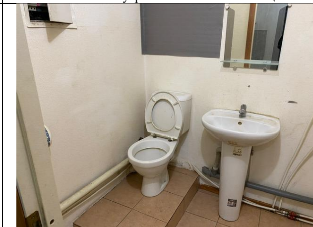
Фото № 26 – Внутреннее состояние помещения
