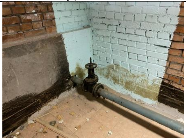
Фото № 18 – Внутреннее состояние помещения
