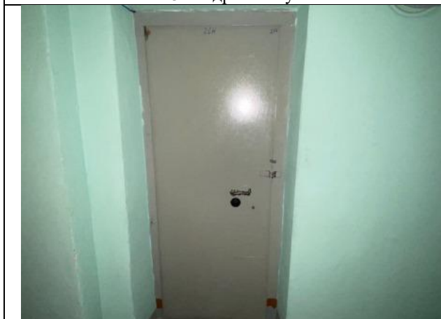
Фото № 5 – Вход в помещение
