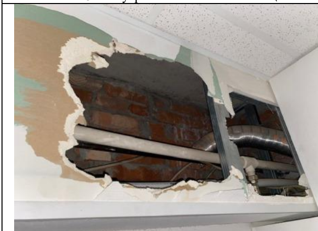
Фото № 17 – Внутреннее состояние помещения
