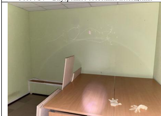
Фото № 11 – Внутреннее состояние помещения
