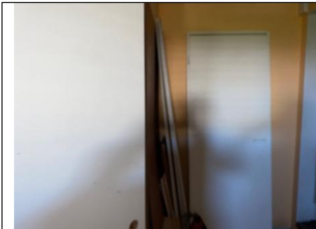
Фото № 21 – Внутреннее состояние помещения
