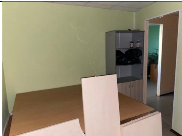
Фото № 14 – Внутреннее состояние помещения
