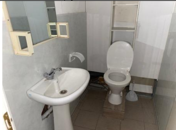
Фото № 16 – Внутреннее состояние помещения
