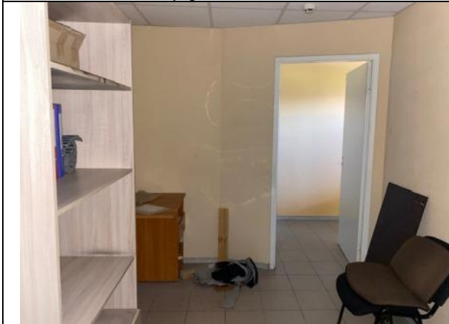
Фото № 23 – Внутреннее состояние помещения
