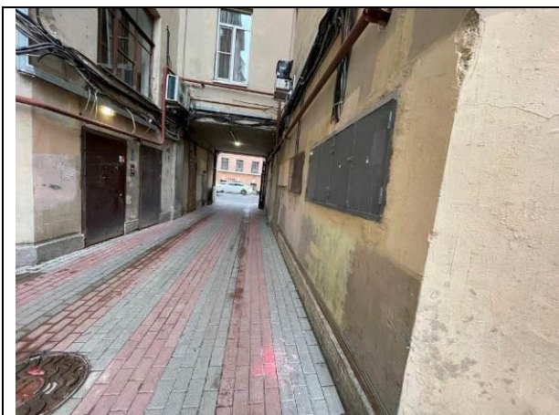
Фото 15. Проход через арку к Объекту оценки
