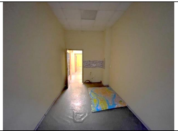
Фото 32. Типичное состояние Объекта оценки
