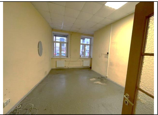
Фото 40. Типичное состояние Объекта оценки
