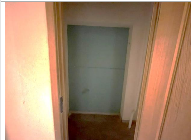
Фото 43. Типичное состояние Объекта оценки
