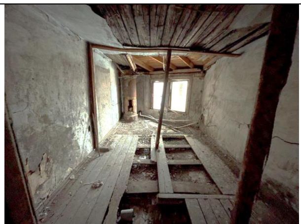
Фото 30. Типичное состояние Объекта оценки
