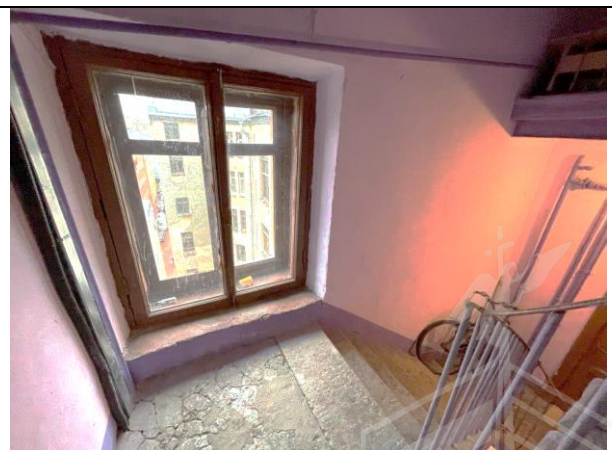
Фото 20. Лестничный проём Объекта оценки
