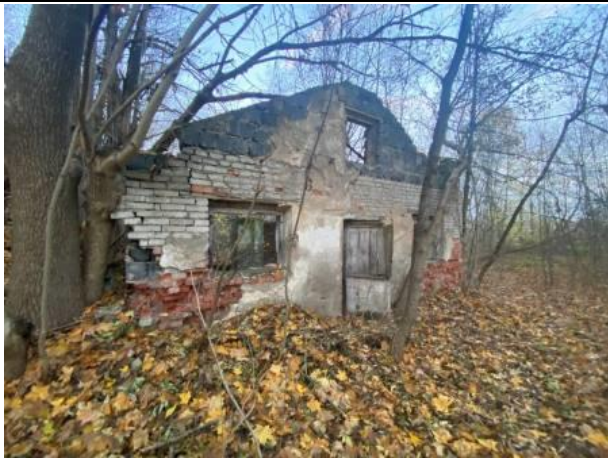
Фото № 5. Внешний вид здания литера З
