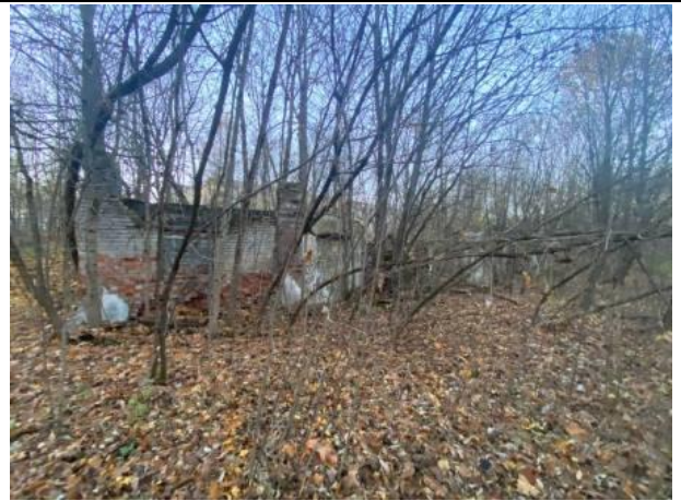
Фото № 6. Внешний вид здания литера З
