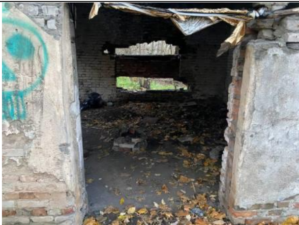
Фото № 7. Внешний вид здания литера Д
