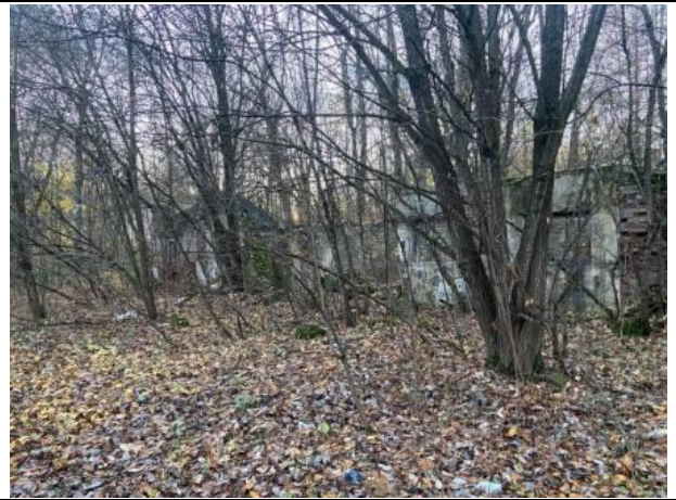
Фото № 12. Внешний вид здания литера К
