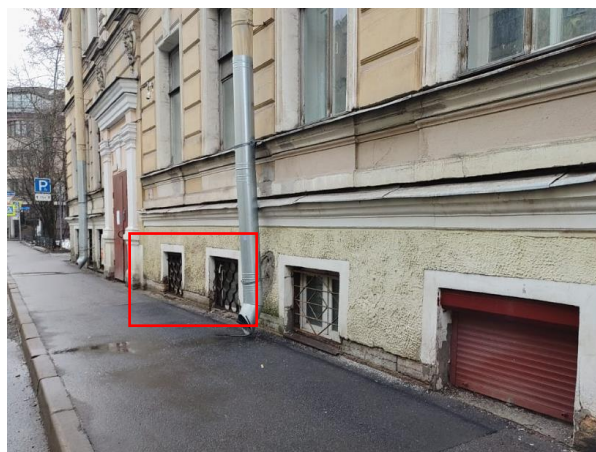
Фото 8. Вид окон Объекта оценки
