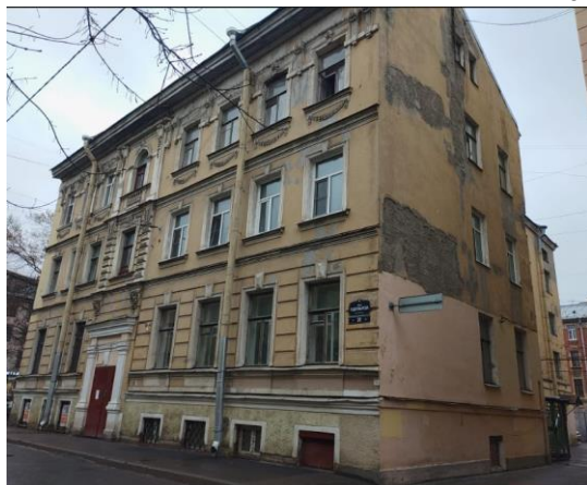
Фото 1. Вид здания, в котором расположен Объект оценки
