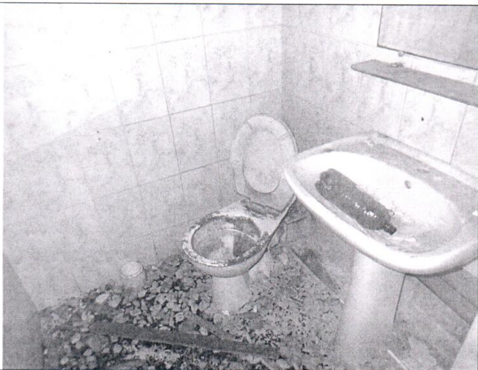
Описание: Вид внутри Объекта (ч.п. 5)
