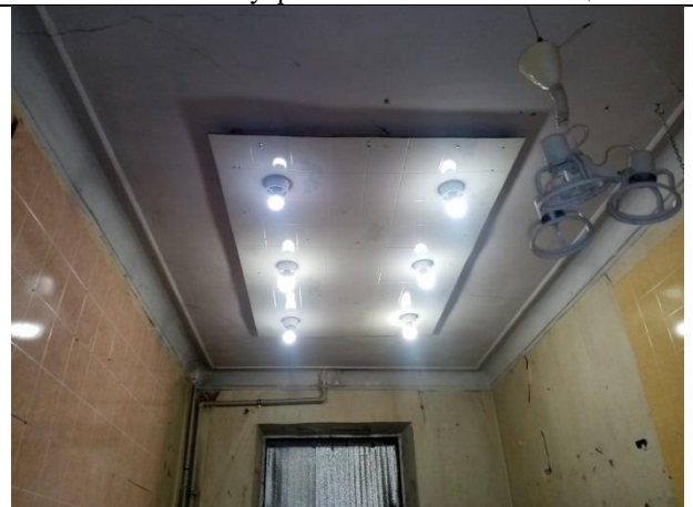
Фото № 16 – Внутреннее состояние помещения
