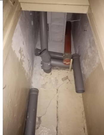
Фото № 14 – Внутреннее состояние помещения
