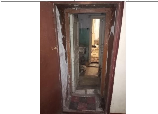
Фото № 9 – Внутреннее состояние помещения
