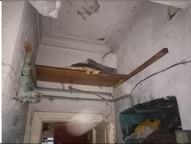
Фото № 11 – Внутреннее состояние помещения
