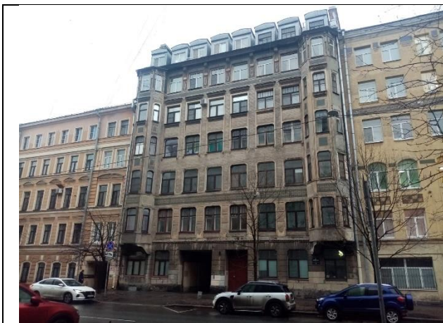
Фото № 1 – Здание, в котором находится Объект оценки
