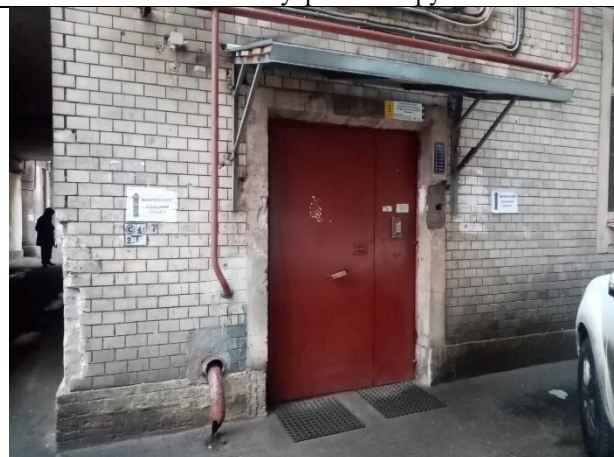
Фото № 6 – Вход в помещение со двора
