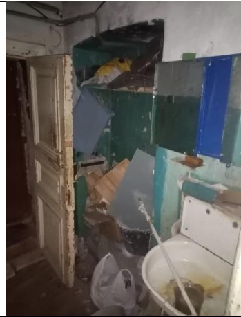
Фото № 12 – Внутреннее состояние помещения
