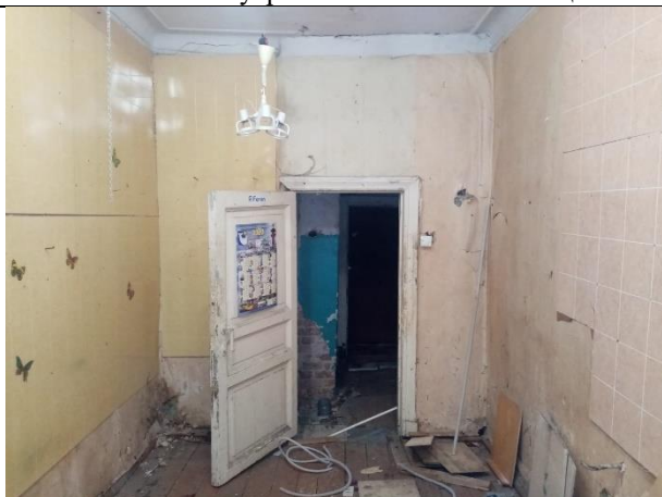
Фото № 17 – Внутреннее состояние помещения
