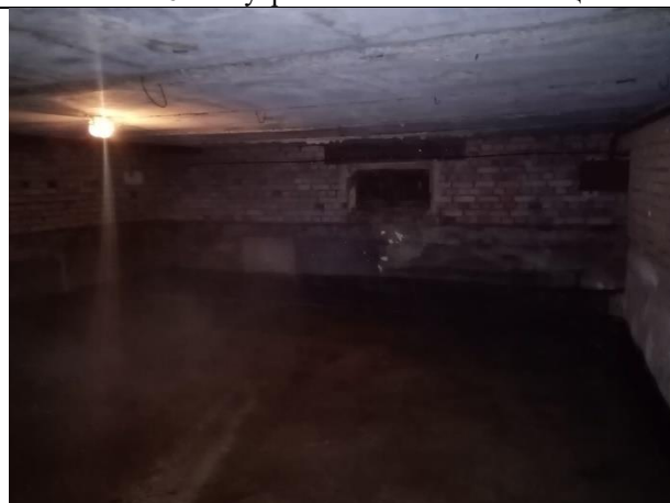
Фото № 18 – Внутреннее состояние помещения
