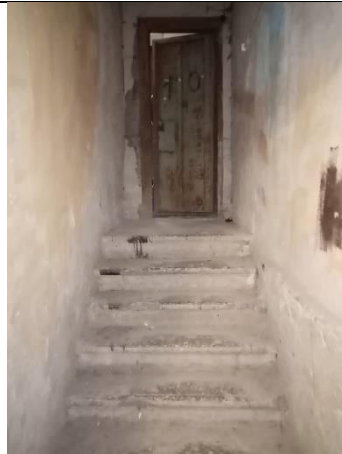
Фото № 8 – Внутреннее состояние помещения
