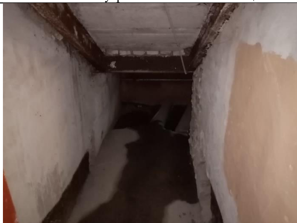
Фото № 11 – Помещение II - проход к помещению I
