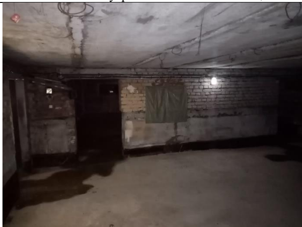
Фото № 15 – Внутреннее состояние помещения
