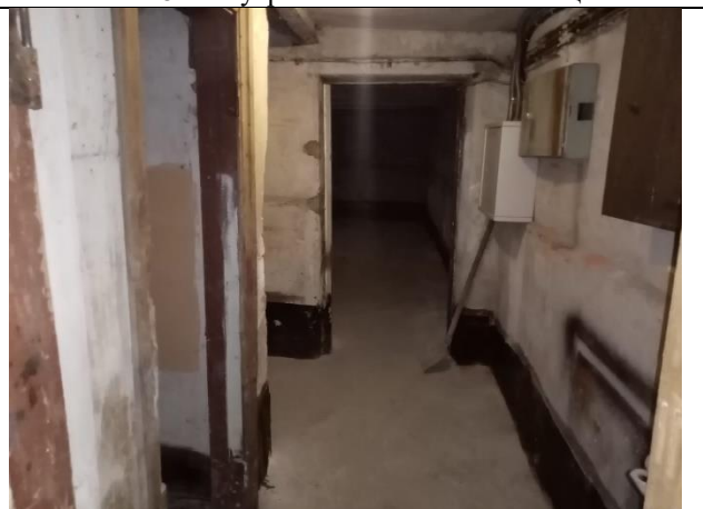
Фото № 10 – Внутреннее состояние помещения
