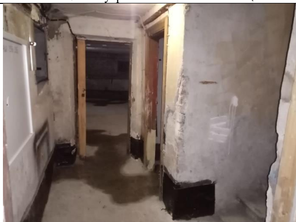
Фото № 9 – Внутреннее состояние помещения
