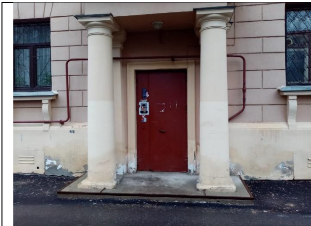
Фото № 5 – Общий вход в помещение
