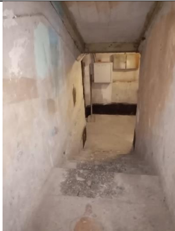
Фото № 7 – Внутреннее состояние помещения
