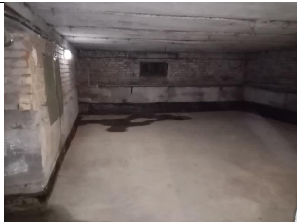
Фото № 14 – Внутреннее состояние помещения
