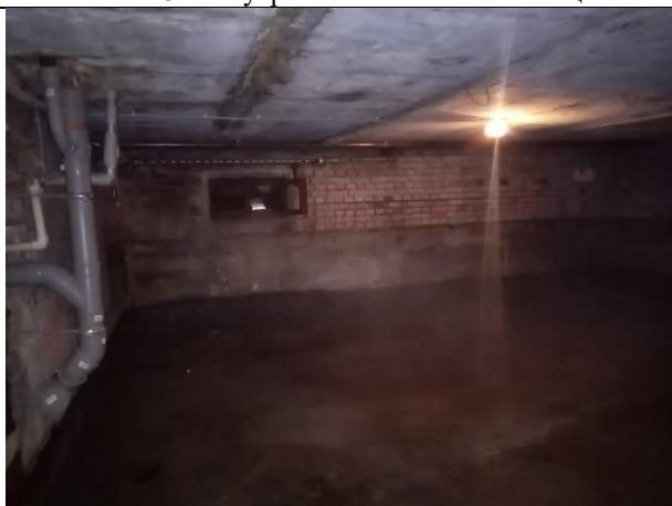
Фото № 17 – Внутреннее состояние помещения
