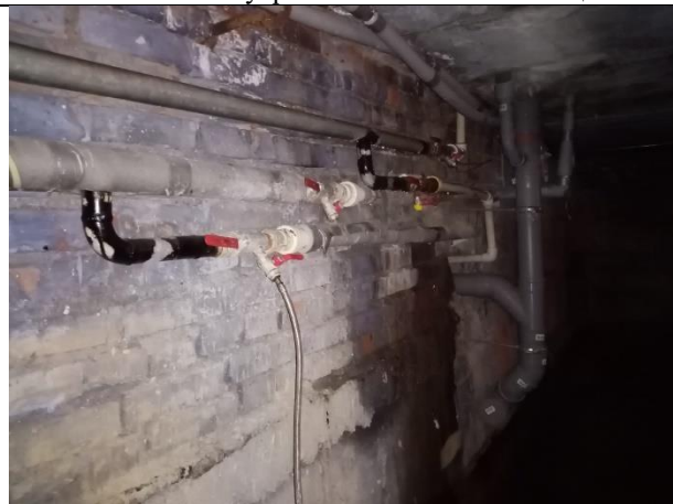
Фото № 16 – Внутреннее состояние помещения
