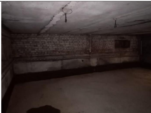
Фото № 13 – Внутреннее состояние помещения
