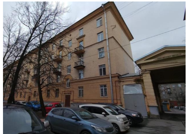
Фото 2. Вид здания Объекта оценки. Ближайшее окружение
