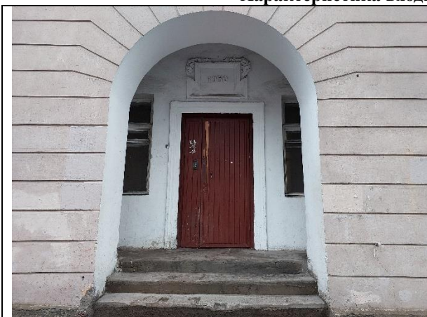
Фото 5. Общий вход Объекта оценки с улицы
