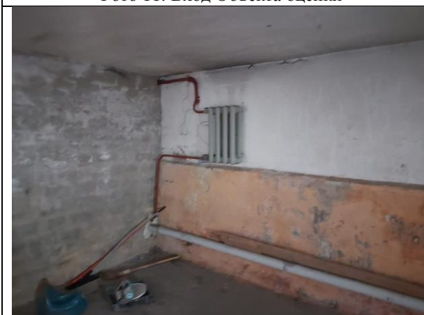
Фото 13. Внутреннее состояние Объекта оценки
