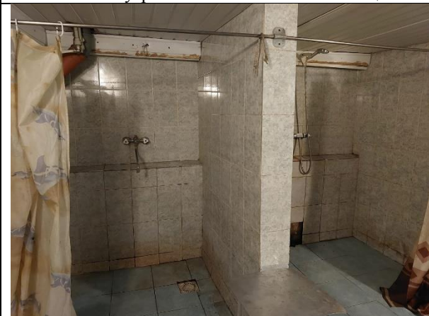
Фото 21. Внутреннее состояние Объекта оценки
