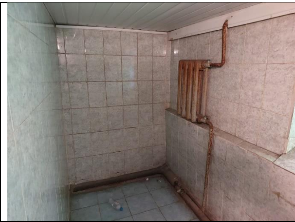
Фото 15. Внутреннее состояние Объекта оценки
