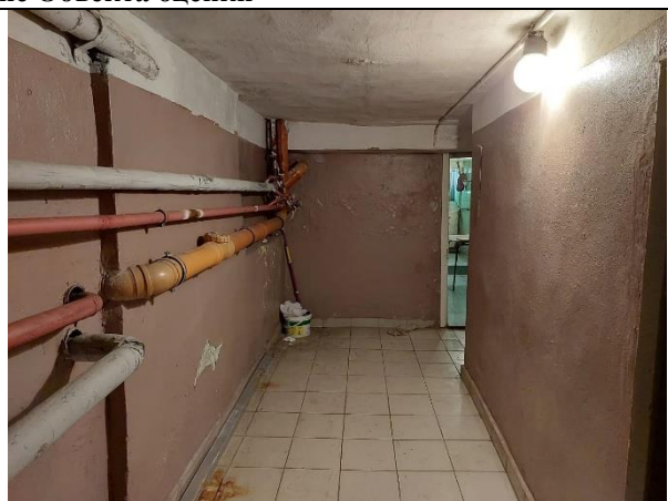
Фото 12. Внутреннее состояние Объекта оценки
