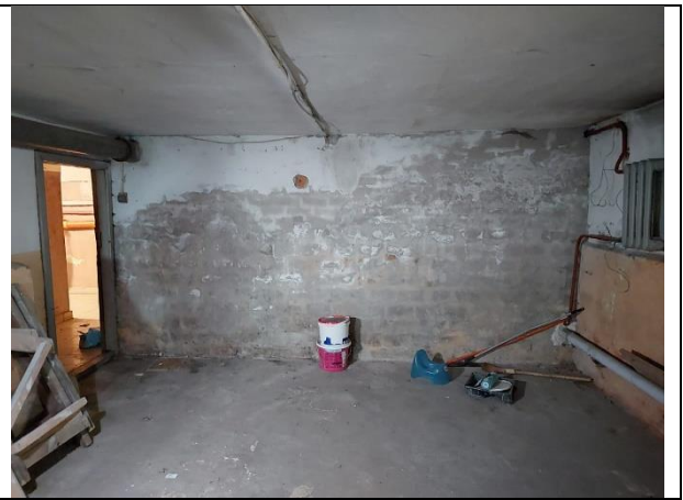
Фото 16. Внутреннее состояние Объекта оценки
