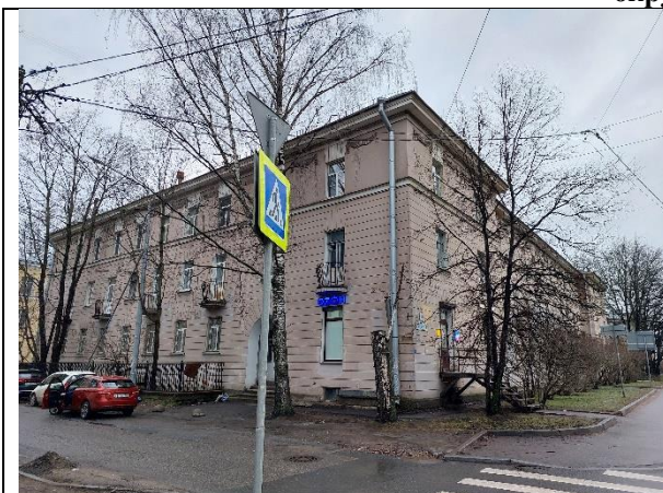
Фото 1. Вид здания, в котором расположен Объект оценки
