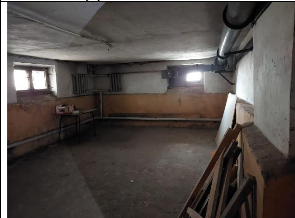
Фото 17. Внутреннее состояние Объекта оценки
