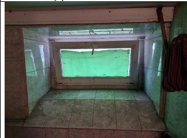
Фото 19. Внутреннее состояние Объекта оценки
