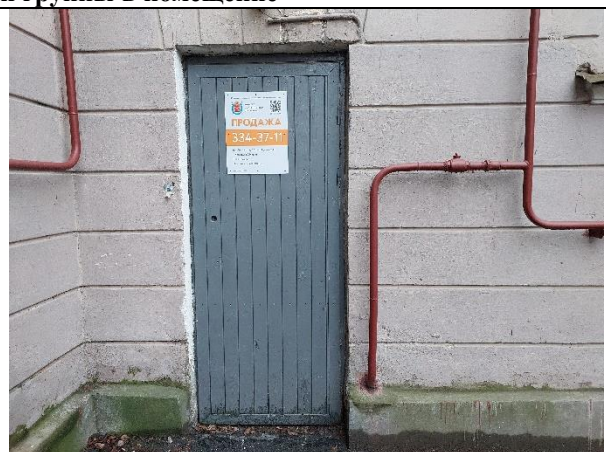
Фото 6. Общий вход Объекта оценки со двора
