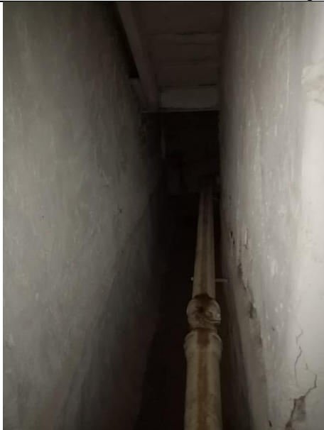
Фото № 9 – Внутреннее состояние помещения
