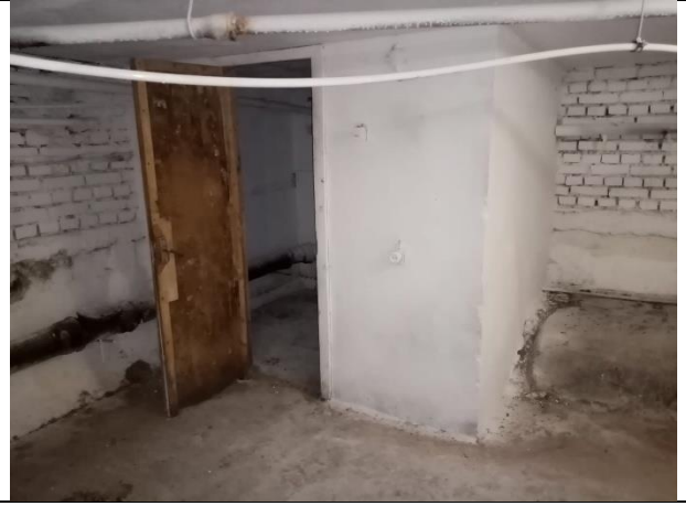
Фото № 14 – Внутреннее состояние помещения
