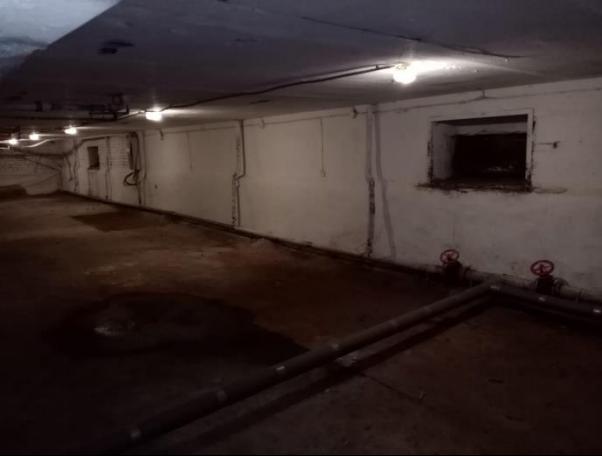
Фото № 15 – Внутреннее состояние помещения
