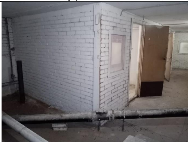
Фото № 33 – Внутреннее состояние помещения
