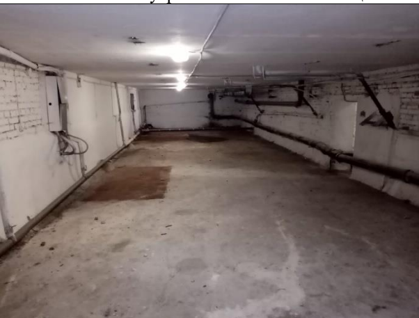
Фото № 19 – Внутреннее состояние помещения
