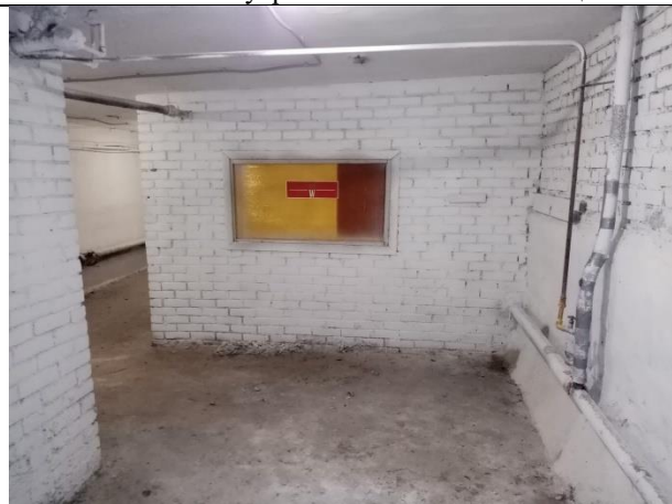
Фото № 24 – Внутреннее состояние помещения
