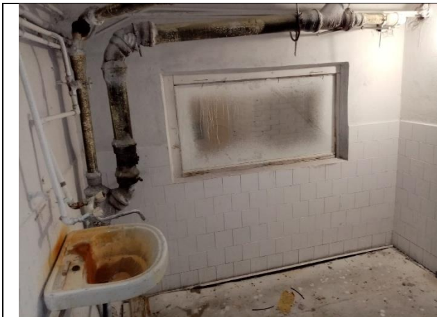
Фото № 21 – Внутреннее состояние помещения
