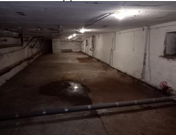
Фото № 17 – Внутреннее состояние помещения
