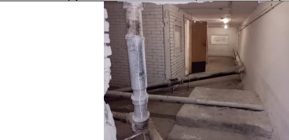
Фото № 35 – Внутреннее состояние помещения
