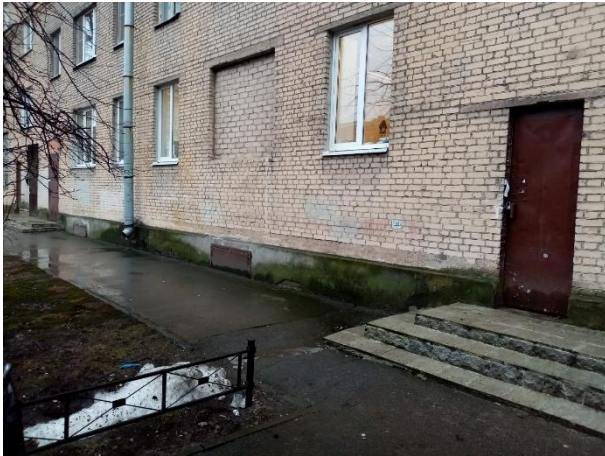
Фото № 7 – Вход в помещение со двора
