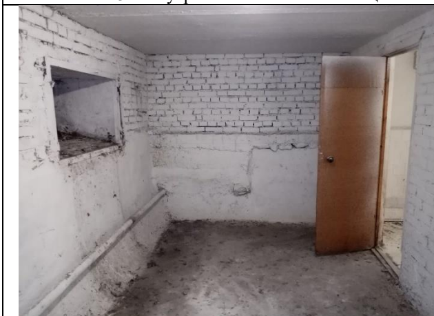
Фото № 25 – Внутреннее состояние помещения
