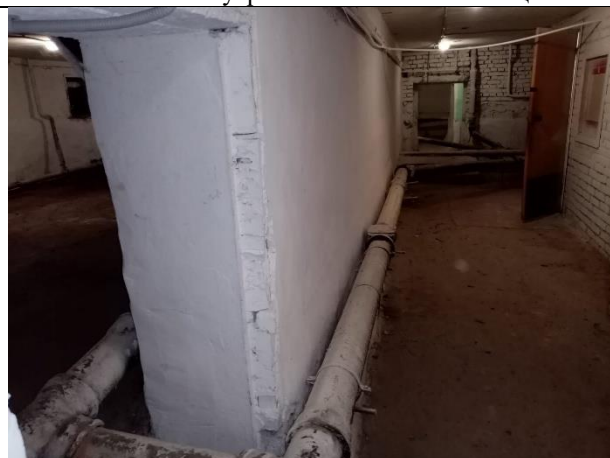
Фото № 26 – Внутреннее состояние помещения
