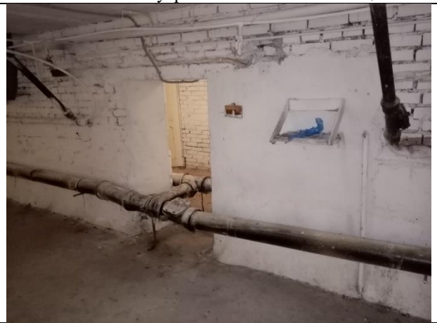
Фото № 18 – Внутреннее состояние помещения
