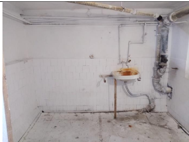
Фото № 22 – Внутреннее состояние помещения
