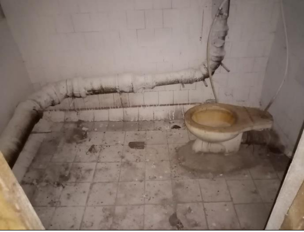
Фото № 13 – Внутреннее состояние помещения
