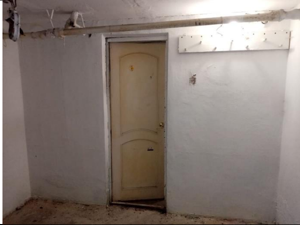
Фото № 29 – Внутреннее состояние помещения
