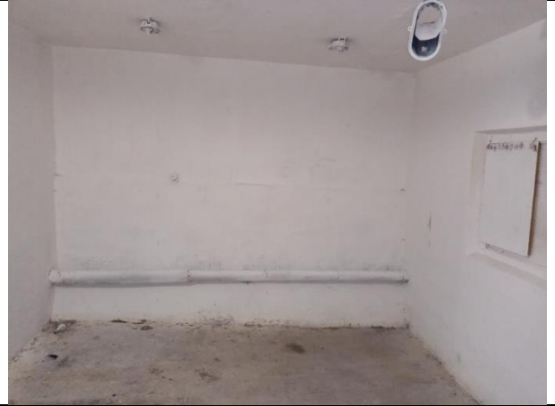
Фото № 30 – Внутреннее состояние помещения
