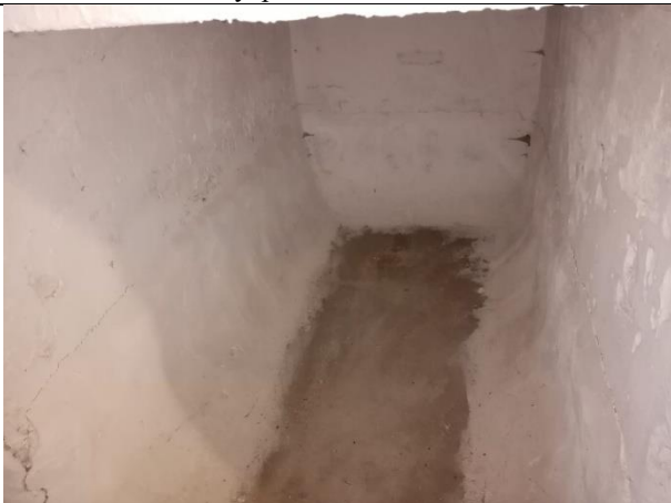
Фото № 11 – Внутреннее состояние помещения
