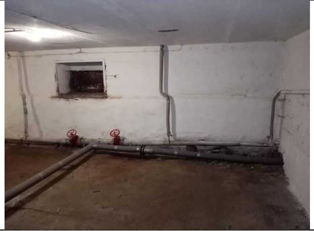
Фото № 16 – Внутреннее состояние помещения
