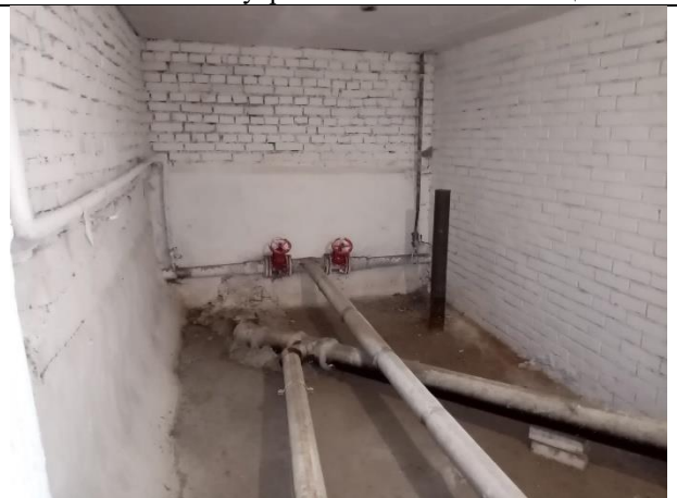
Фото № 34 – Внутреннее состояние помещения
