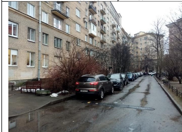
Фото № 5 – Подъездные пути к зданию
