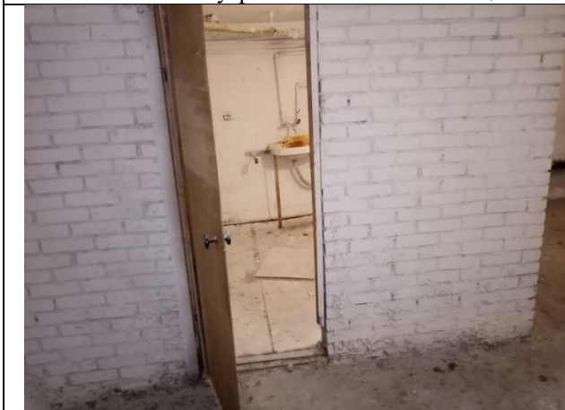
Фото № 23 – Внутреннее состояние помещения
