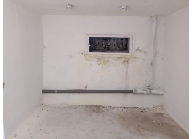
Фото № 32 – Внутреннее состояние помещения
