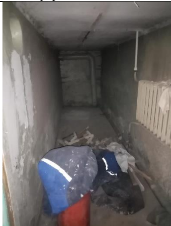
Фото № 11 – Внутреннее состояние помещения
