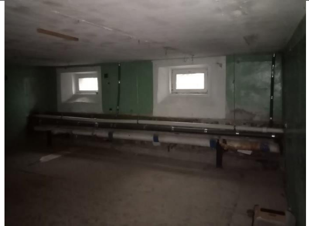
Фото № 30 – Внутреннее состояние помещения
