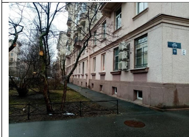
Фото № 3 – Подъездные пути к зданию
