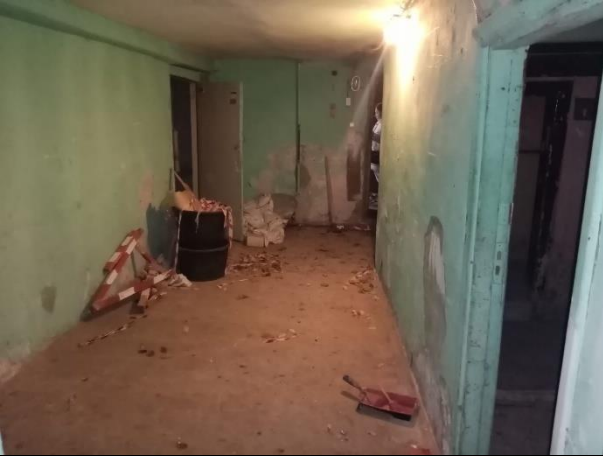
Фото № 13 – Внутреннее состояние помещения
