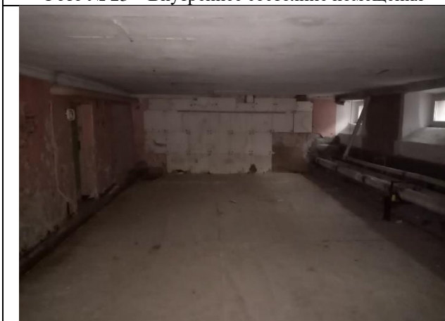
Фото № 25 – Внутреннее состояние помещения
