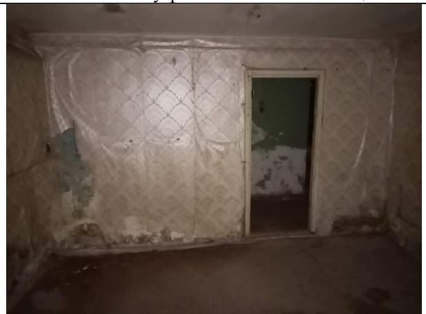
Фото № 32 – Внутреннее состояние помещения
