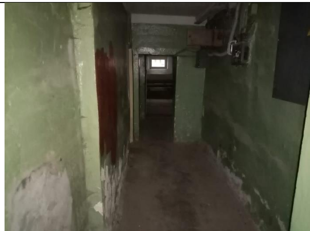
Фото № 20 – Общий вход в помещение
