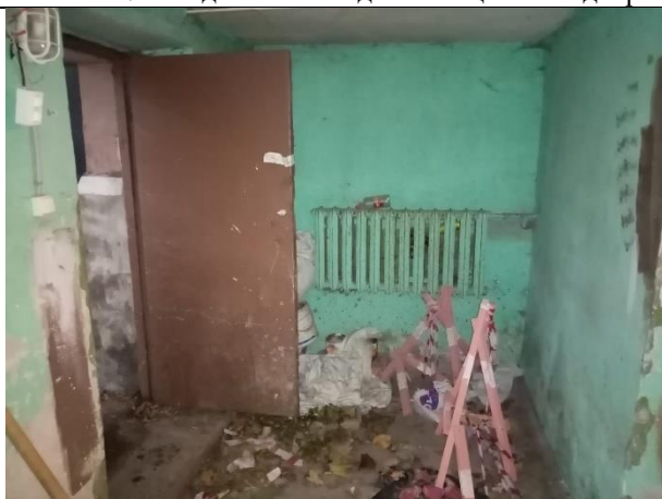
Фото № 9 – Внутреннее состояние помещения
