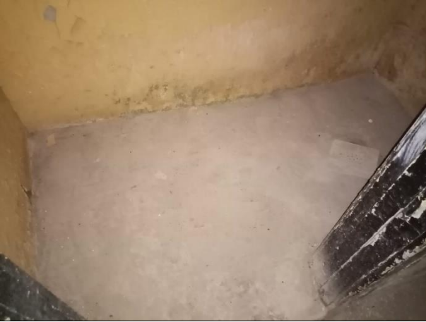
Фото № 15 – Внутреннее состояние помещения
