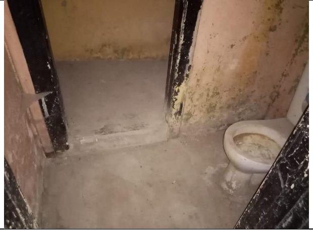
Фото № 16 – Внутреннее состояние помещения
