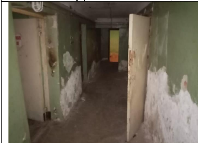
Фото № 21 – Внутреннее состояние помещения
