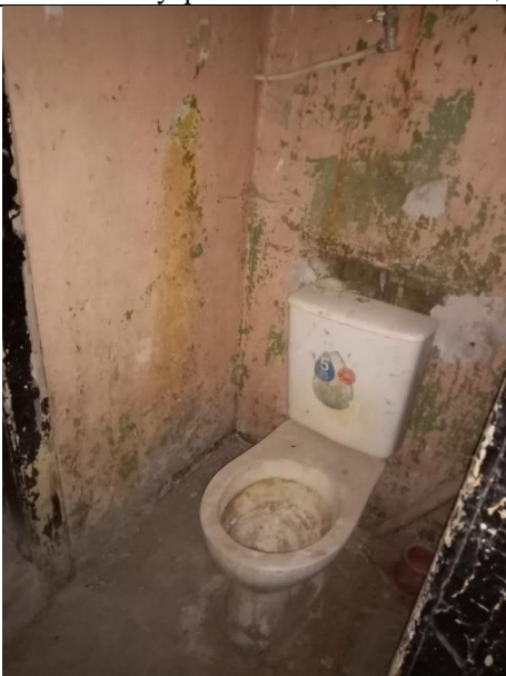
Фото № 17 – Внутреннее состояние помещения
