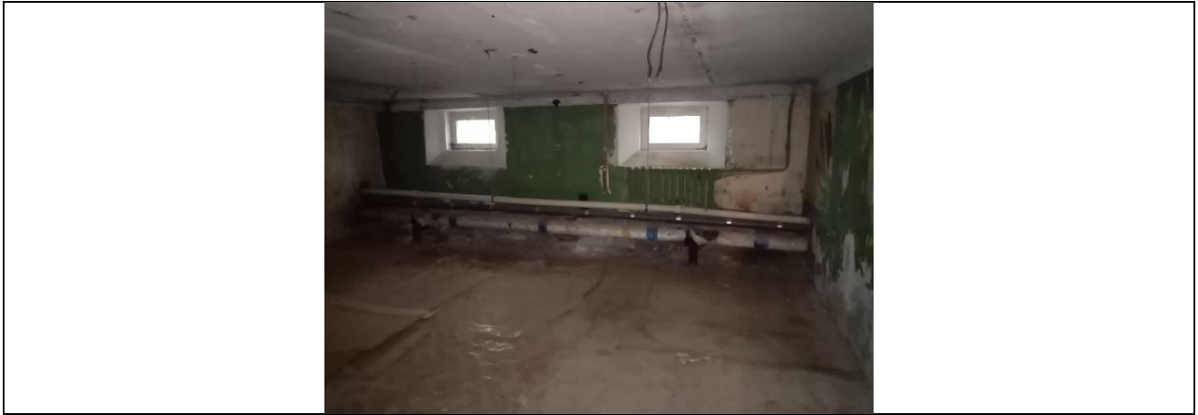
Фото № 35 – Внутреннее состояние помещения
