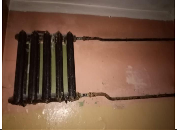
Фото № 14 – Внутреннее состояние помещения
