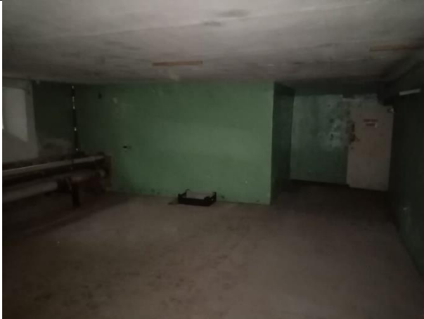
Фото № 29 – Внутреннее состояние помещения
