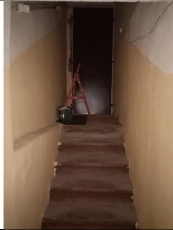
Фото № 28 – Внутреннее состояние помещения
