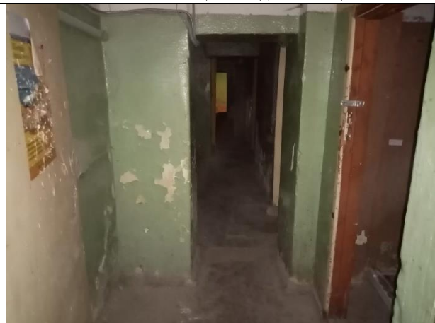
Фото № 22 – Общий вход в помещение
