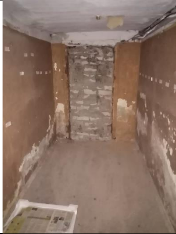
Фото № 27 – Внутреннее состояние помещения
