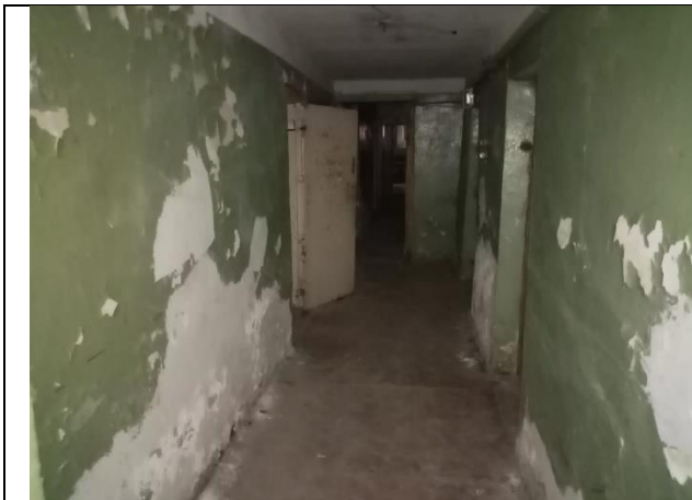
Фото № 19 – Внутреннее состояние помещения
