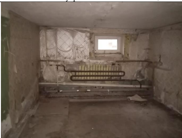
Фото № 33 – Внутреннее состояние помещения
