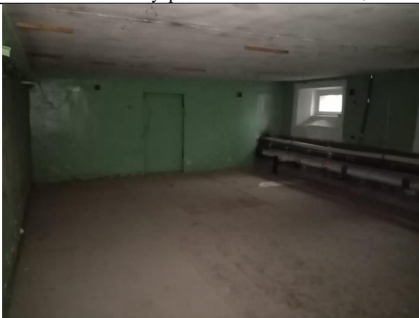
Фото № 31 – Внутреннее состояние помещения
