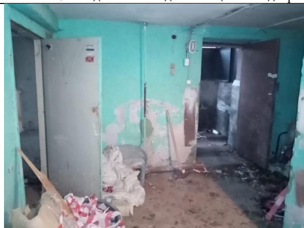
Фото № 10 – Внутреннее состояние помещения
