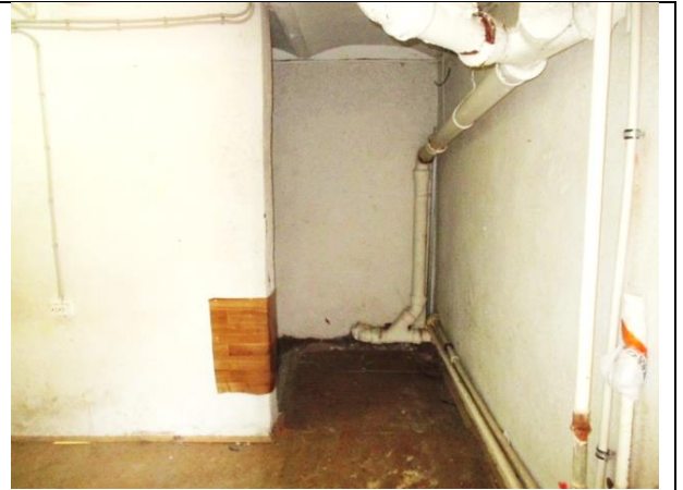
Фото 12. Внутреннее состояние Объекта оценки
