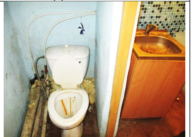
Фото 26. Внутреннее состояние Объекта оценки
