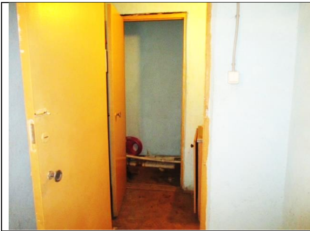
Фото 23. Внутреннее состояние Объекта оценки
