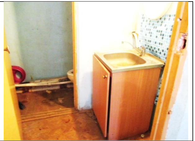
Фото 24. Внутреннее состояние Объекта оценки
