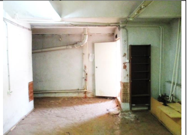
Фото 14. Внутреннее состояние Объекта оценки
