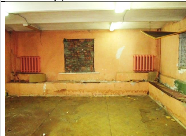
Фото 21. Внутреннее состояние Объекта оценки
