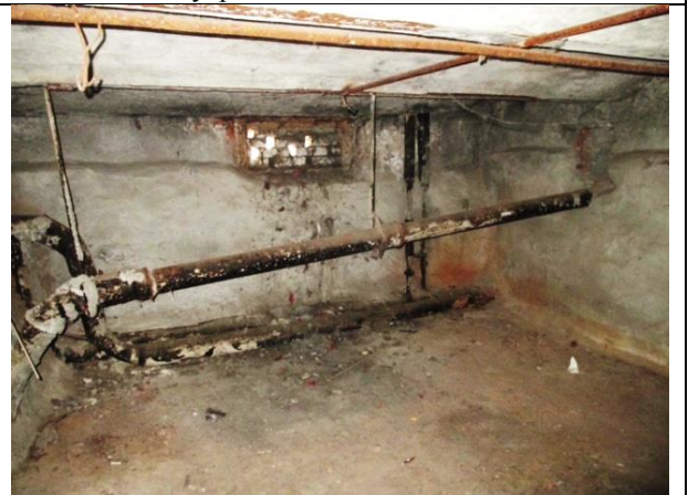
Фото 18. Внутреннее состояние Объекта оценки
