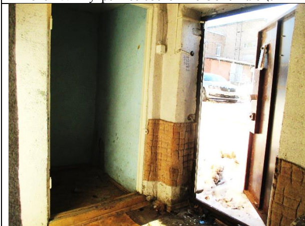
Фото 19. Внутреннее состояние Объекта оценки
