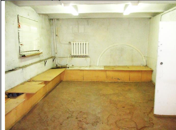
Фото 13. Внутреннее состояние Объекта оценки
