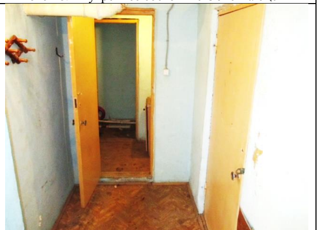
Фото 20. Внутреннее состояние Объекта оценки
