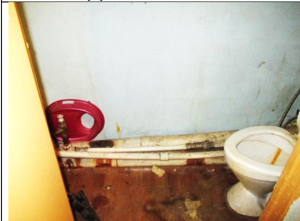
Фото 25. Внутреннее состояние Объекта оценки
