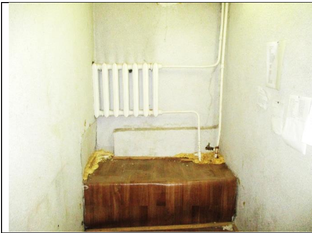
Фото 15. Внутреннее состояние Объекта оценки
