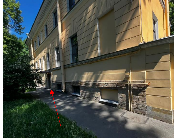
Фото 8. Общий вход с улицы Объекта оценки
