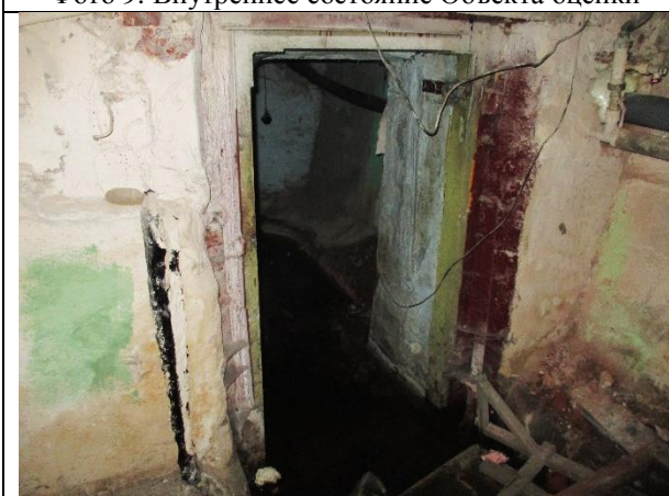
Фото 11. Внутреннее состояние Объекта оценки
