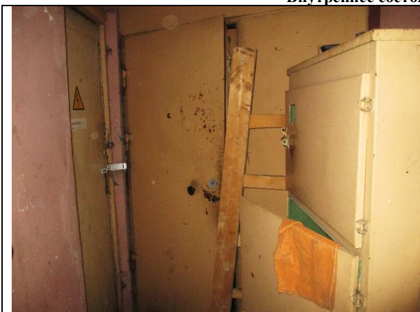
Фото 11. Внутреннее состояние Объекта оценки
