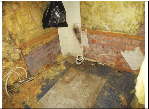
Фото 16. Внутреннее состояние Объекта оценки
