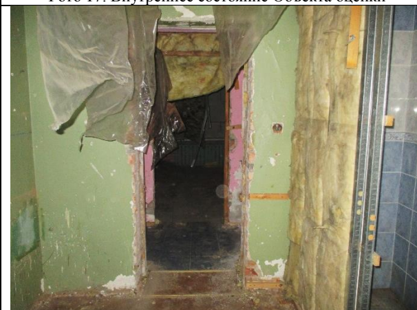
Фото 19. Внутреннее состояние Объекта оценки
