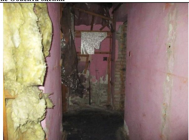
Фото 12. Внутреннее состояние Объекта оценки
