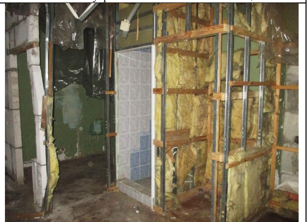
Фото 18. Внутреннее состояние Объекта оценки
