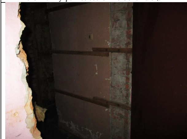
Фото 13. Внутреннее состояние Объекта оценки
