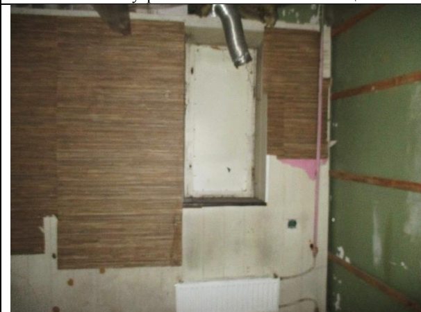
Фото 17. Внутреннее состояние Объекта оценки
