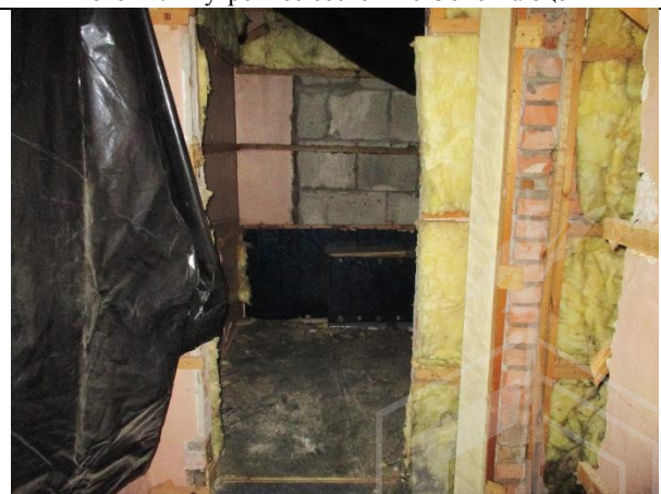
Фото 14. Внутреннее состояние Объекта оценки
