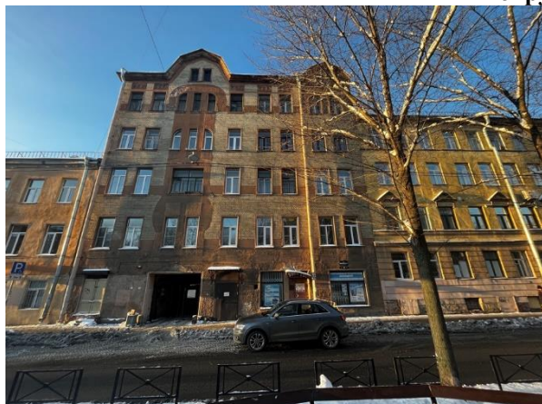
Фото 1. Вид здания, в котором расположен Объект оценки
