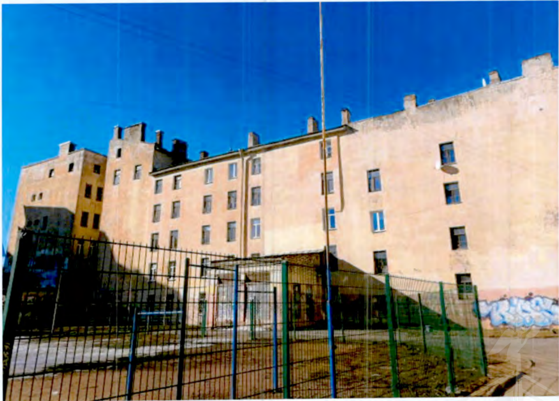
7. Общий вид юго-восточного фасада юго-восточного флигеля объекта культурного наследия (фото от 05.03.2024).
