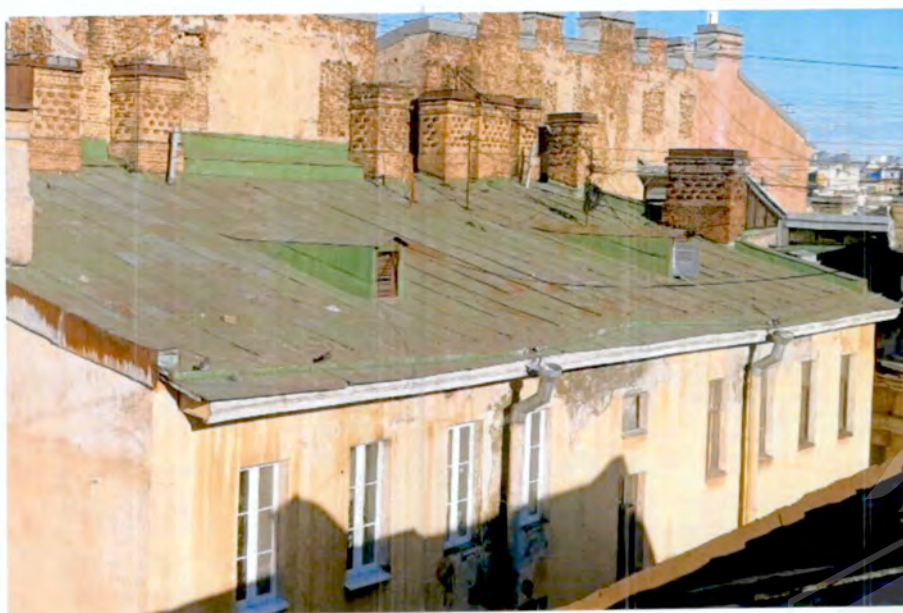
29. Кровля объекта культурного наследия (фото от 05.03.2023).
