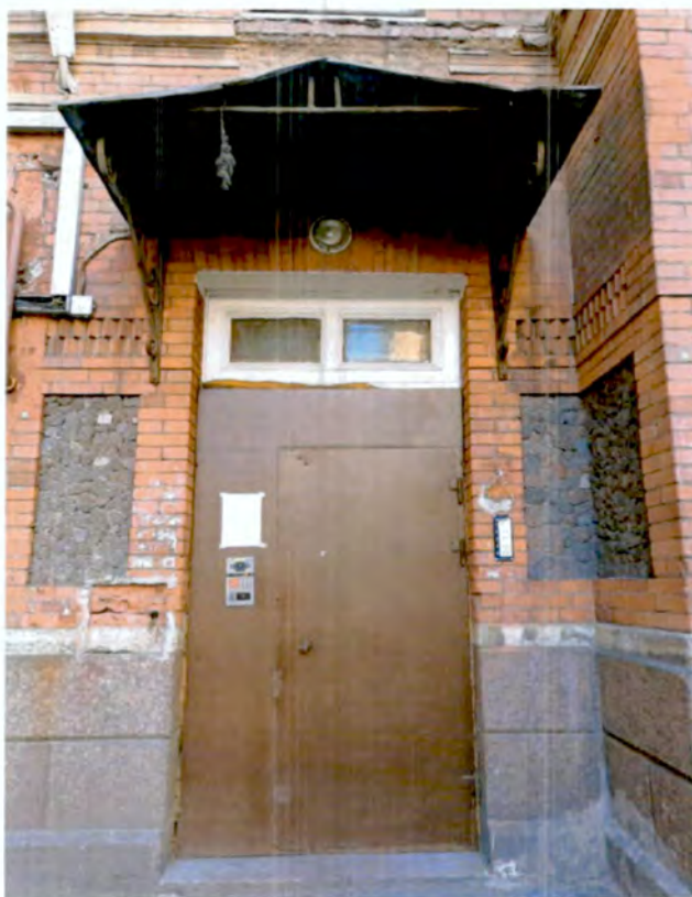
12. Фрагмент северо-восточного фасада юго-западного флигеля объекта культурного наследия (фото от 05.03.2024).
