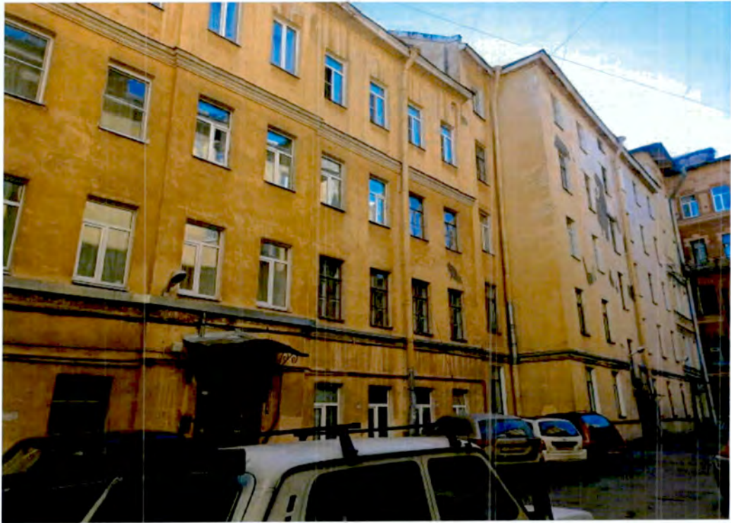
4. Общий вид северо-западного фасада юго-восточного флигеля объекта культурного наследия (фото от 05.03.2024).
