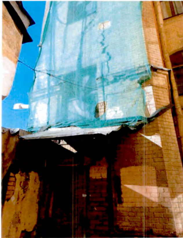
14. Фрагмент юго-восточного фасада юго-западного флигеля объекта культурного наследия (фото от 05.03.2024).
