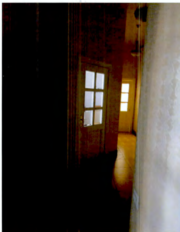
33. Интерьер объекта культурного наследия. Помещение № 4 в уровне 2-го этажа (фото от 05.03.2024).
