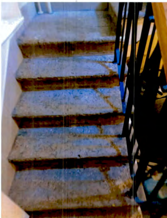
34. Интерьер объекта культурного наследия. Помещение 1ЛК (фото от 05.03.2024).
