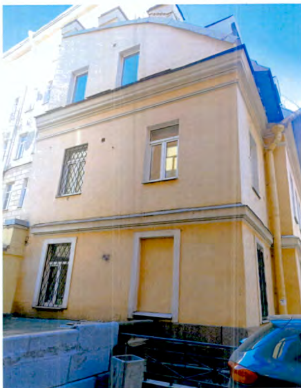
31. Общий вид юго-западного фасада объекта культурного наследия (фото от 05.03.2024).
