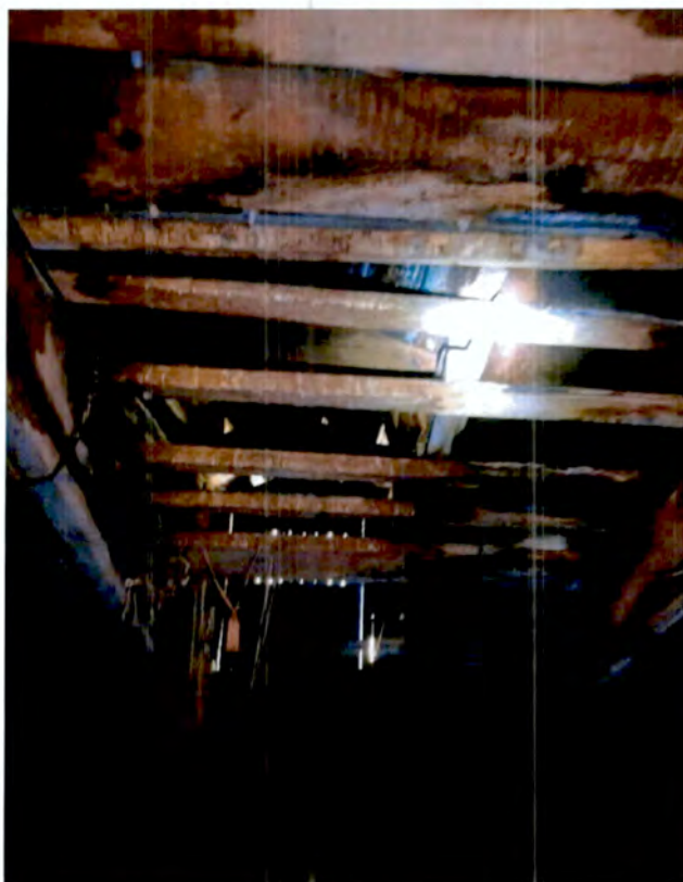
26. Чердачное пространство объекта культурного наследия (фото от 05.03.2024).
