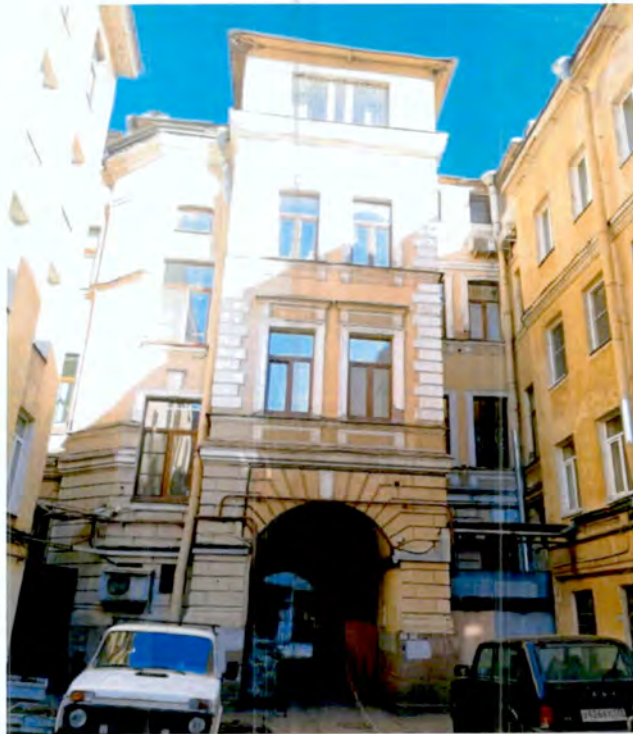
2. Общий вид юго-западного фасада лицевого флигеля объекта культурного наследия (фото от 05.03.2024).
