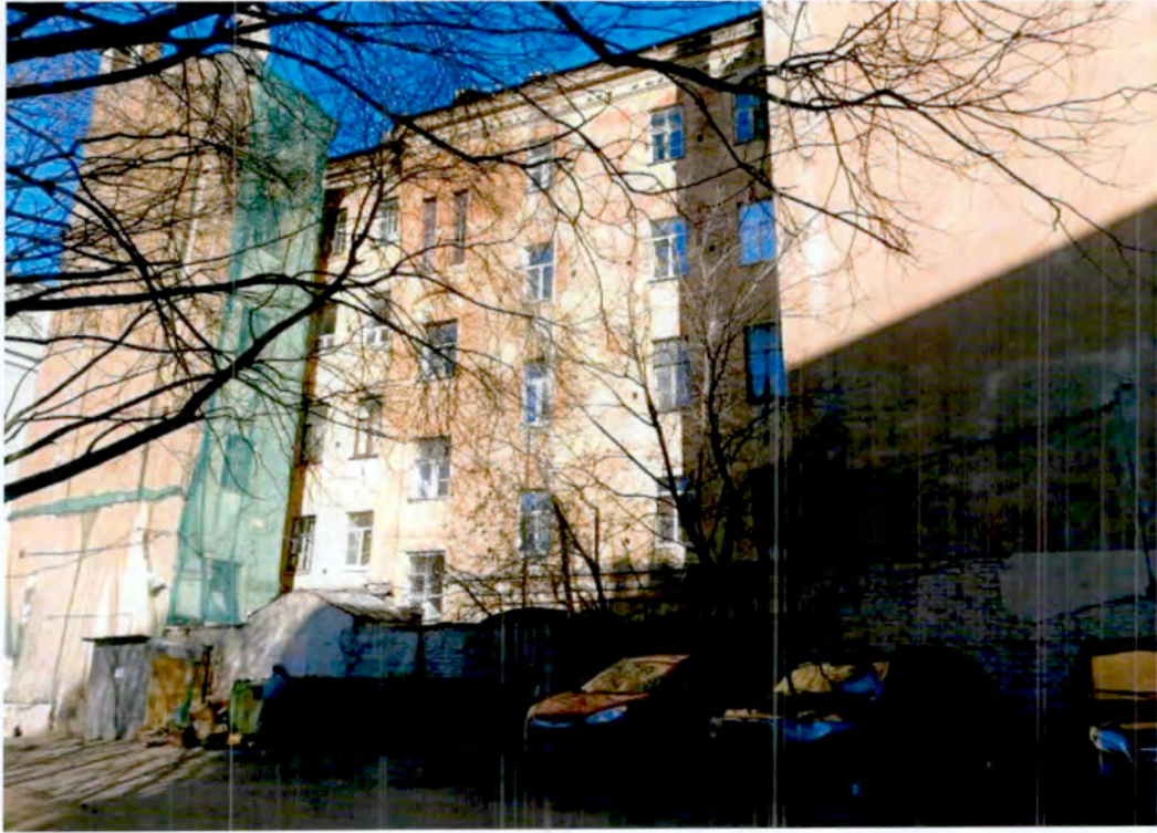
6. Общий вид юго-западного фасада юго-западного флигеля объекта культурного наследия (фото от 05.03.2024).
