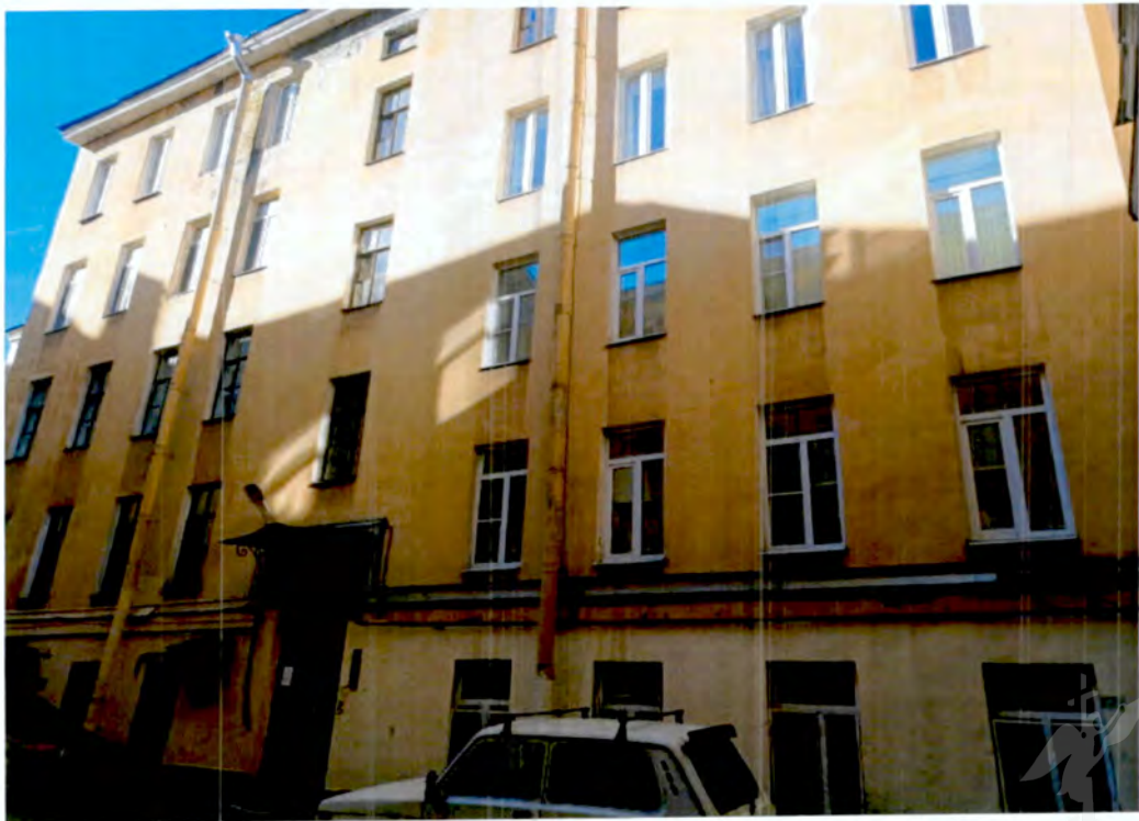
5. Общий вид юго-восточного фасада северо-западного флигеля объекта культурного наследия (фото от 05.03.2024).
