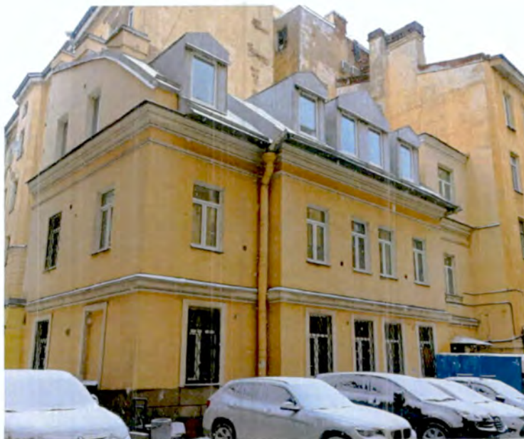
30. Общий вид юго-восточного фасада объекта культурного наследия (фото от 19.04.2024).
