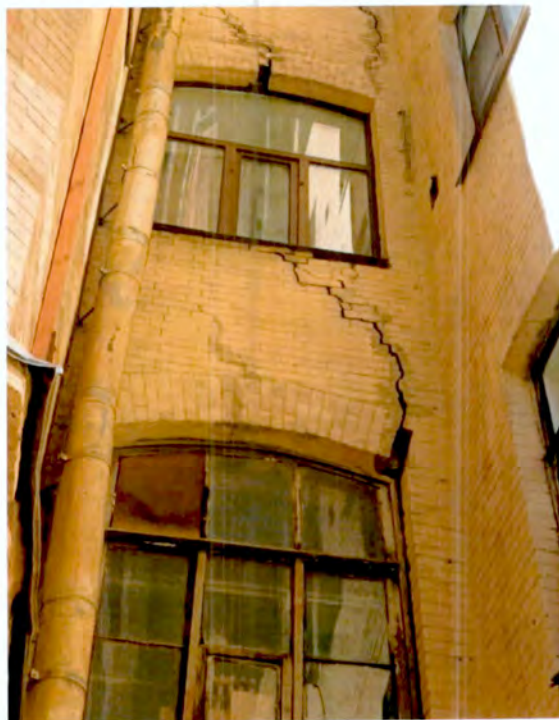
13. Фрагмент юго-восточного фасада юго-западного флигеля объекта культурного наследия (фото от 05.03.2024).
