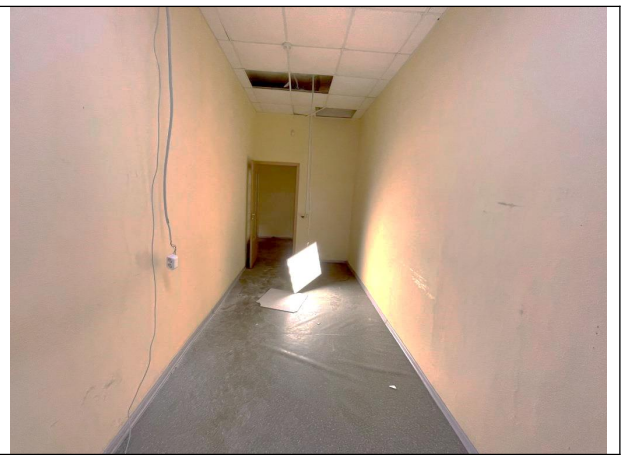
Фото 48. Типичное состояние Объекта оценки
