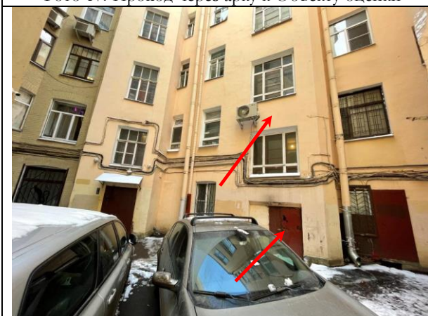
Фото 19. Вид здания расположения Объекта оценки, входная группа Объекта оценки
