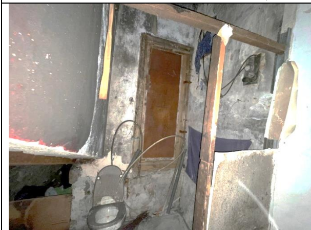
Фото 25. Типичное состояние Объекта оценки
