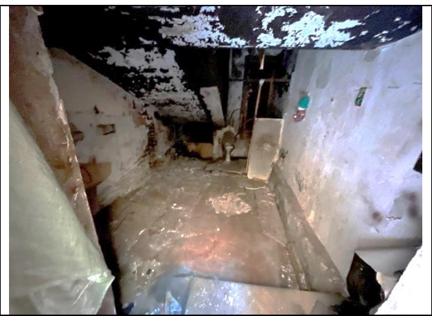
Фото 22. Типичное состояние Объекта оценки
