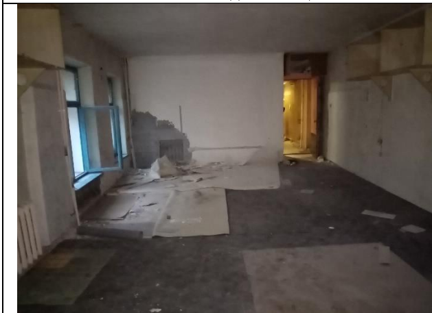
Фото № 7 – Внутреннее состояние помещения
