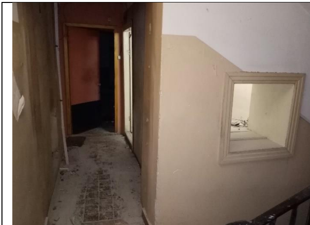
Фото № 5 – Вход в помещение
