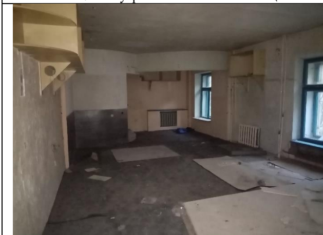
Фото № 9 – Внутреннее состояние помещения
