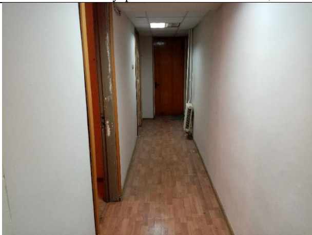
Фото № 17 – Внутреннее состояние помещения
