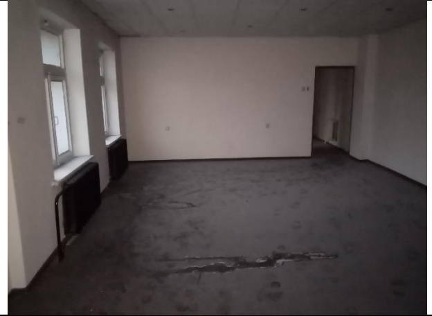
Фото № 22 – Внутреннее состояние помещения
