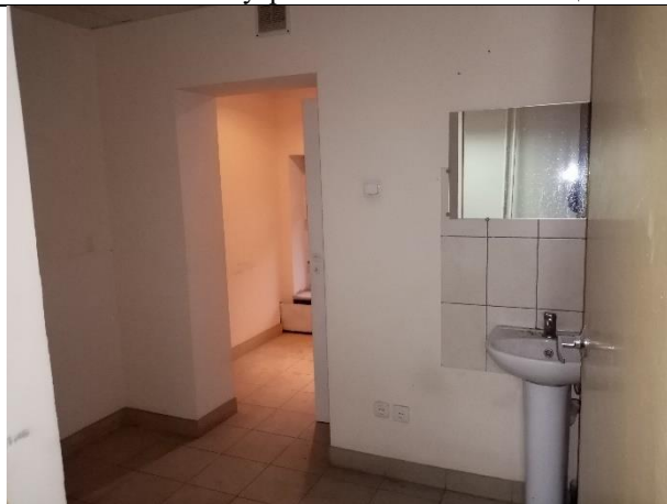
Фото № 18 – Внутреннее состояние помещения
