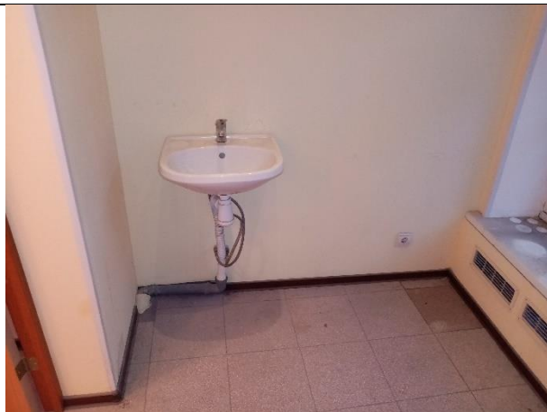
Фото № 14 – Внутреннее состояние помещения
