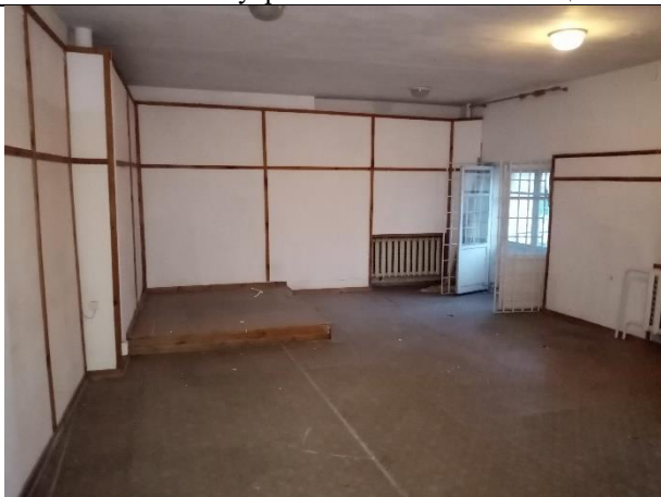
Фото № 15 – Внутреннее состояние помещения
