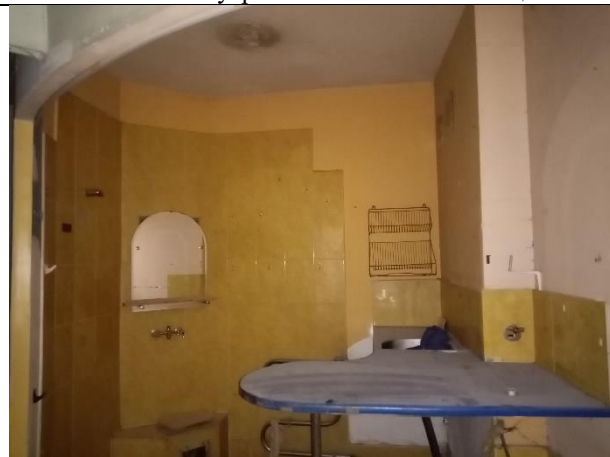
Фото № 8 – Внутреннее состояние помещения
