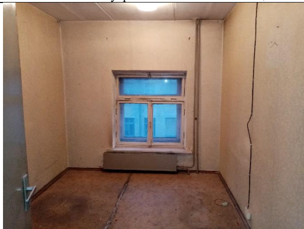
Фото № 16 – Внутреннее состояние помещения
