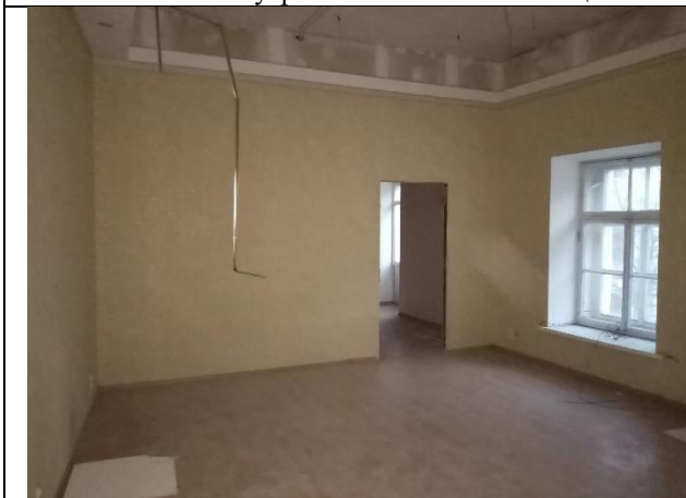
Фото № 11 – Внутреннее состояние помещения
