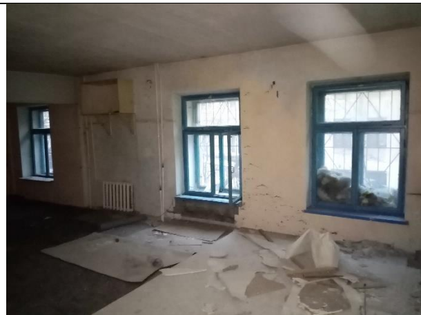
Фото № 6 – Внутреннее состояние помещения
