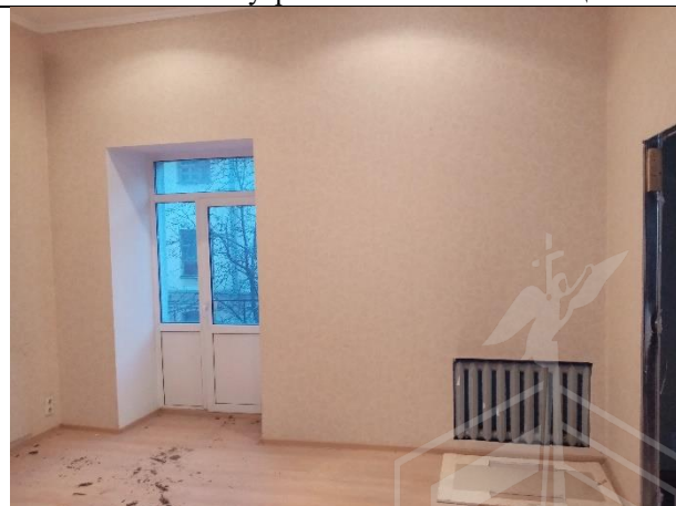
Фото № 12 – Внутреннее состояние помещения
