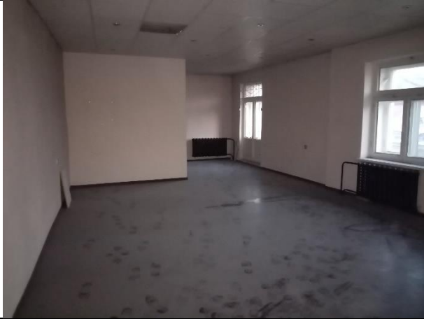
Фото № 21 – Внутреннее состояние помещения
