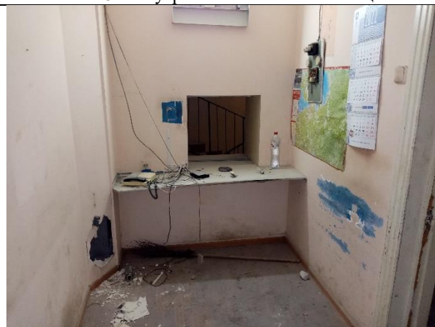
Фото № 10 – Внутреннее состояние помещения
