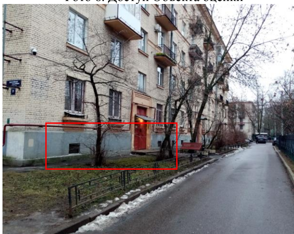
Фото 8. Вид окон Объекта оценки
