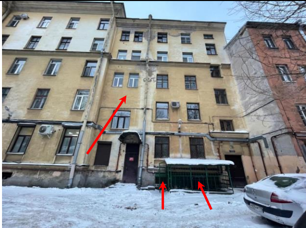
Фото 21. Вид здания расположения Объекта оценки
