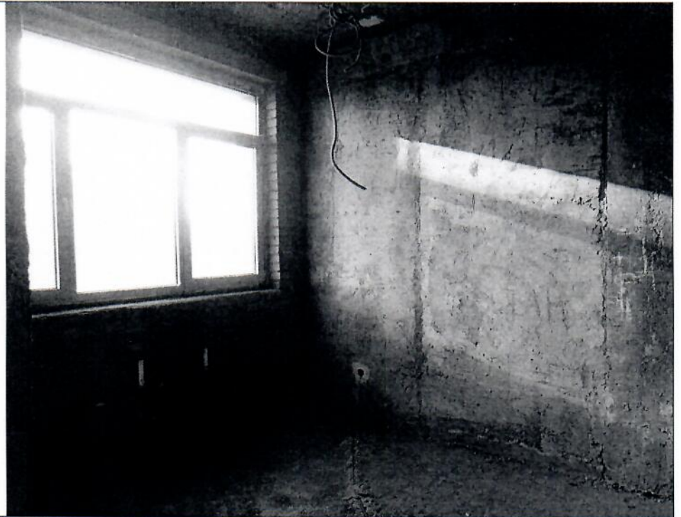
Описание: Вид внутри Объекта
