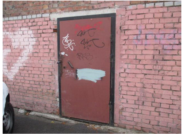
Фото № 10. Вход в здание
