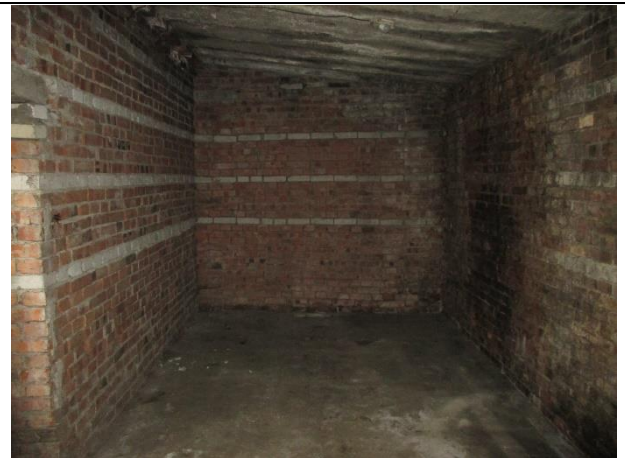
Фото № 12. Внутреннее состояние здания
