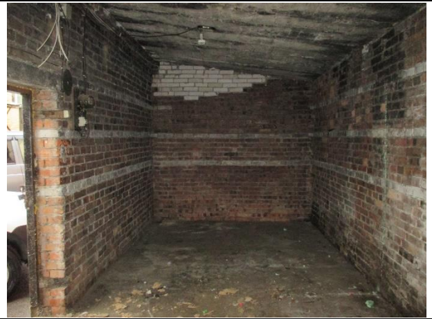
Фото № 16. Внутреннее состояние здания
