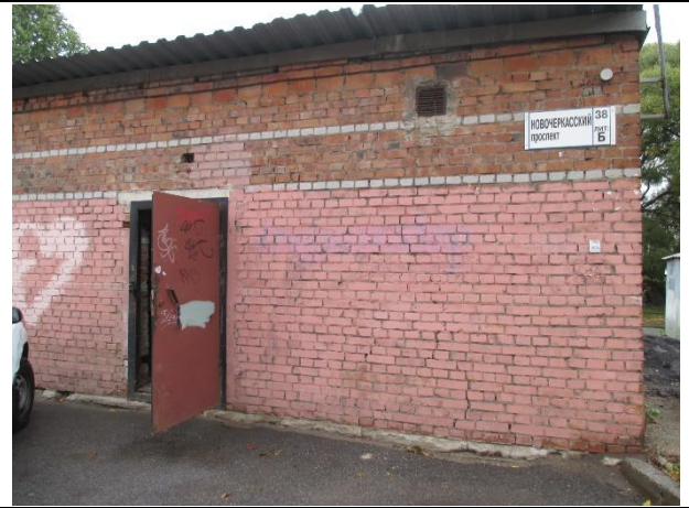
Фото № 8. Внешний вид здания
