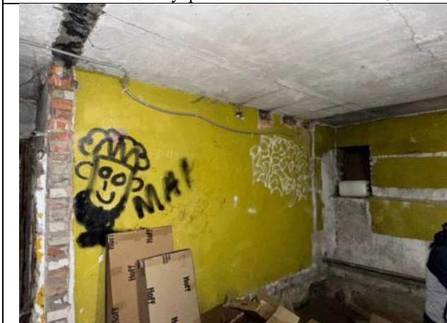
Фото № 15 – Внутреннее состояние помещения
