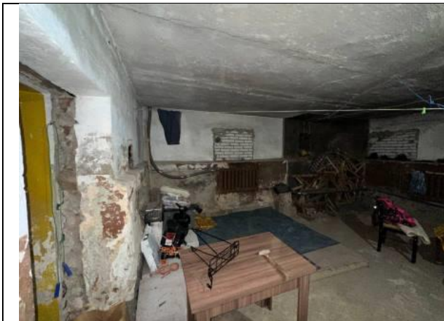
Фото № 13 – Внутреннее состояние помещения
