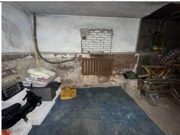
Фото № 11 – Внутреннее состояние помещения
