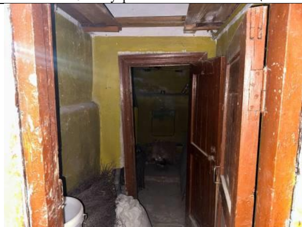
Фото № 18 – Внутреннее состояние помещения
