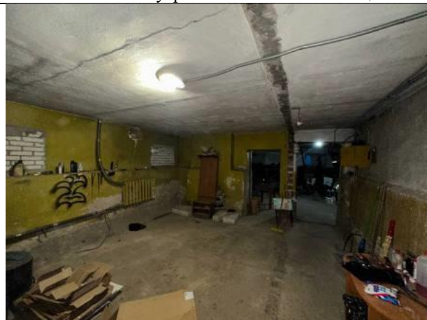
Фото № 16 – Внутреннее состояние помещения
