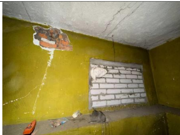
Фото № 14 – Внутреннее состояние помещения
