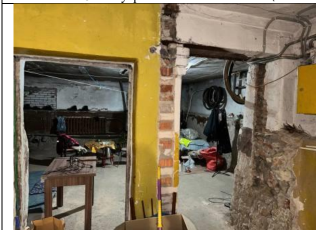
Фото № 17 – Внутреннее состояние помещения
