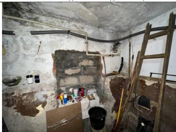
Фото № 10 – Внутреннее состояние помещения
