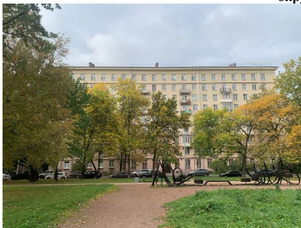
Фото 1. Вид здания, в котором расположен Объект оценки
