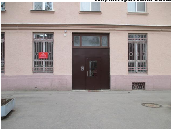
Фото 5. Общий вход с улицы
