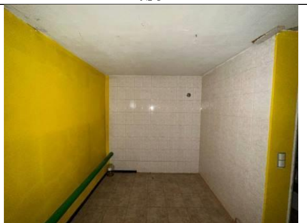
Фото № 20 – Внутреннее состояние помещения
