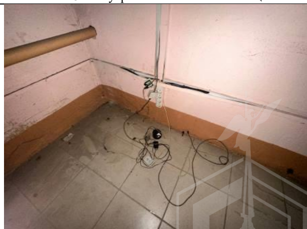
Фото № 12 – Внутреннее состояние помещения
