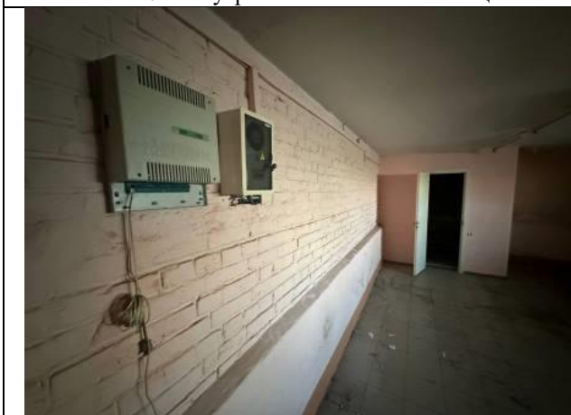
Фото № 11 – Внутреннее состояние помещения
