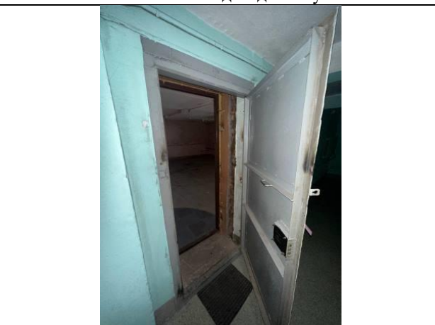
Фото № 6 – Вход в помещение с лестничной клетки № 5
