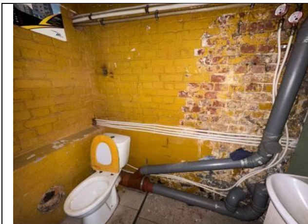
Фото № 13 – Внутреннее состояние помещения
