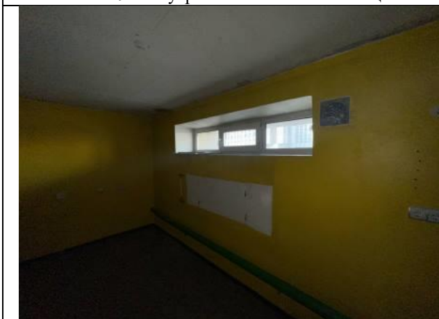
Фото № 21 – Внутреннее состояние помещения
