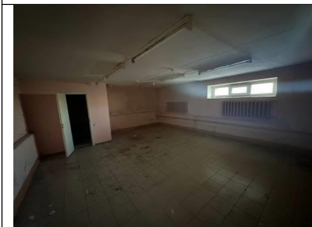
Фото № 7 – Внутреннее состояние помещения
