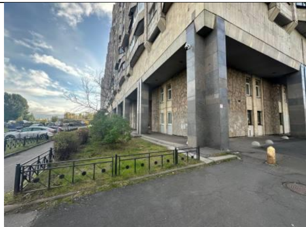
Фото № 4 – Подъездные пути
