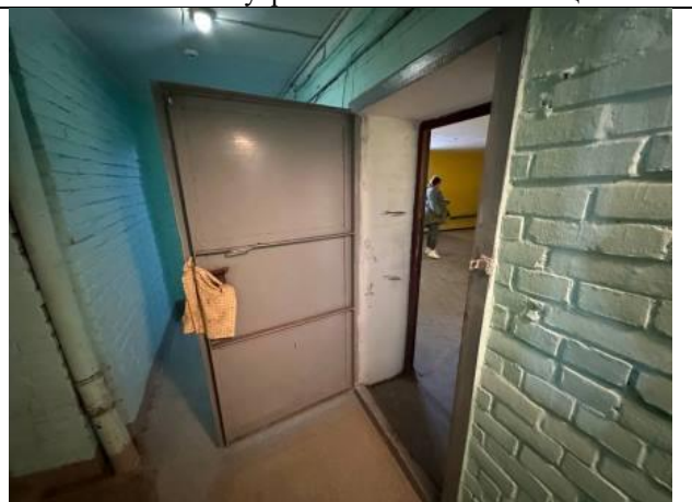
Фото № 18 – Вход в помещение с лестничной клетки № 6
