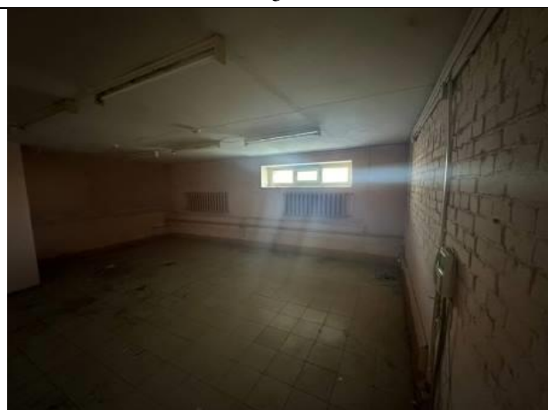
Фото № 8 – Внутреннее состояние помещения
